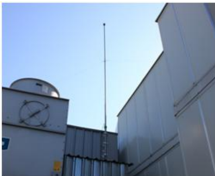
Figura 3.5 - Exemplo de Pára-Raios Ionizante [24]
