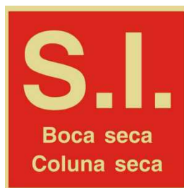
Fig. 5.60 – Sinalização da boca de alimentação (coluna seca)
