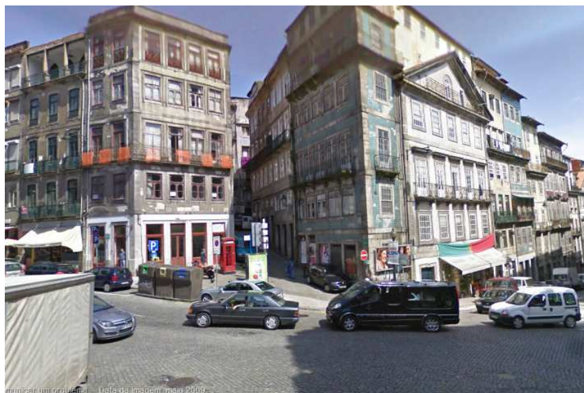
Fig. 5.31 – Local de estacionamento de veículos de socorro
