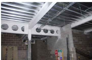
Fig. 6.1 – Pintura intumescente aplicada a perfis metálicos, (Fonte: Serc Evolução, [47])
