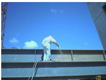
Fig. 6.2 – Projeção de argamassas pastosas, protegendo elementos metálicos, (Fonte: Serc Evolução, [47])
