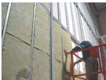
Fig. 6.4 – Painéis de silicato de cálcio (aplicação)
