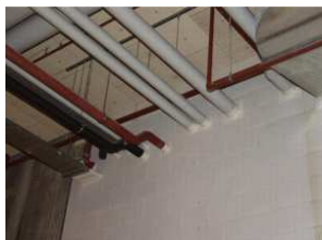
Fig. 6.9 – Resultado final da aplicação de sistemas de selagem, (Fonte: Serc Evolução, [47])
