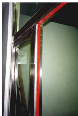
Fig. 6.11 – Tira resistente ao fogo aplicada em janela, (Fonte: Serc Evolução, [47])
