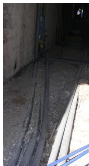
Fig. 46 – Drenagem ao nível da cave
