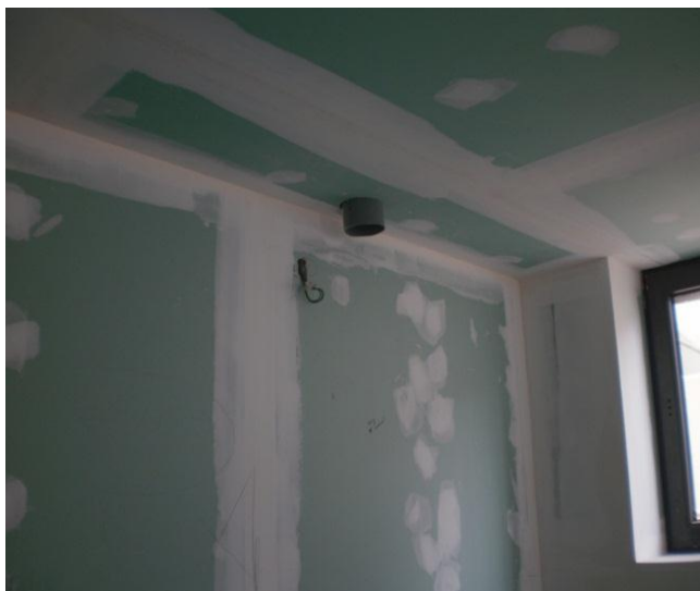
Fig. 61 – Tubo de instalação para exaustor de cozinha
