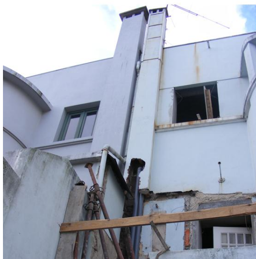
Fig. 57 – Chaminé como elemento de passagem de condutas
