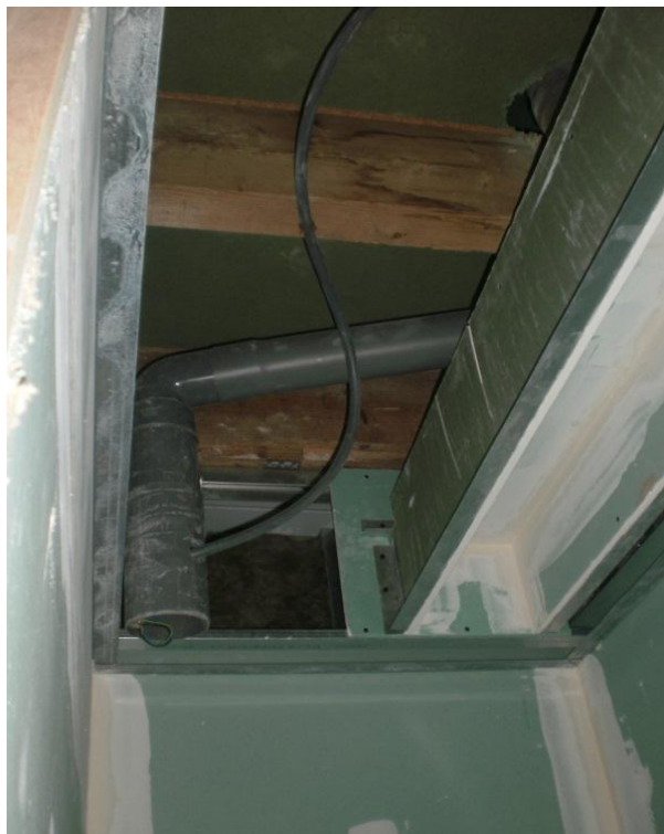
Fig. 62 – Instalação de ventilação em instalação sanitária
