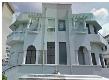
Fig. 30 – Edifício a reabilitar
