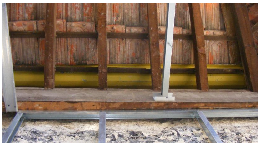
Fig. 53 – Caleiras vistas pelo interior da moradia
