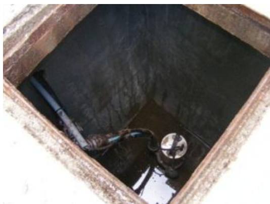
Fig. 45 – Caixa de visita
