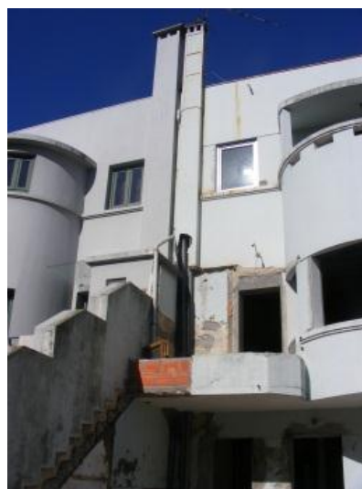
Fig. 48 – Tubos de queda da drenagem doméstica
