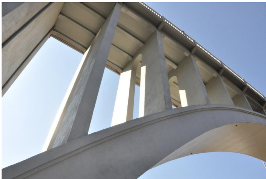
Figura 3.6 - Pilares da Ponte sobre o arco
