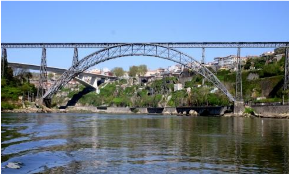
Figura 2.15 – Ponte D. Maria Pia [23]
