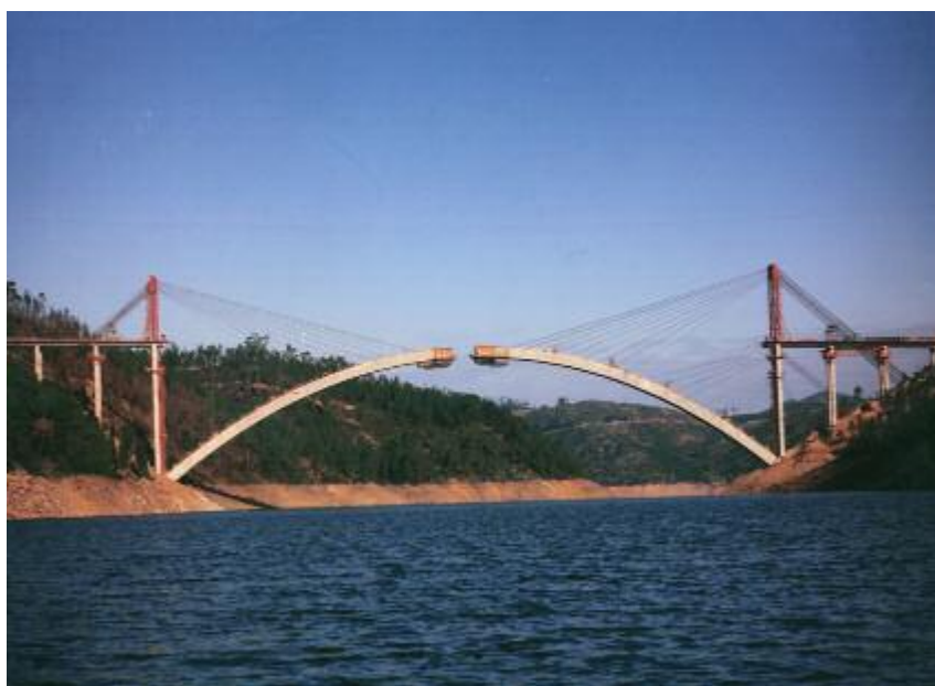
Figura 2.20 - Processo construtivo da ponte sobre o rio Zêzere [28]
