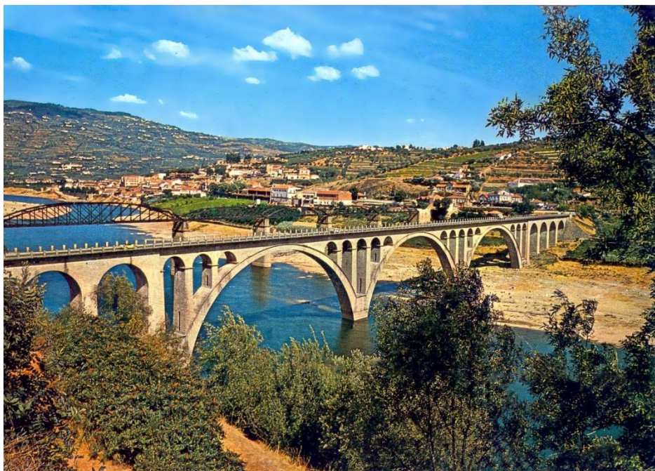
Figura 2.17 – Ponte de alvenaria da Régua sobre o rio Douro [26]
