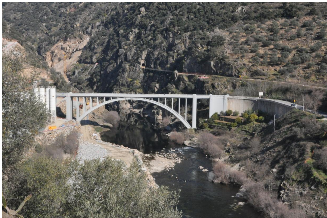
Figura 3.2 - Vista panorâmica da ponte
