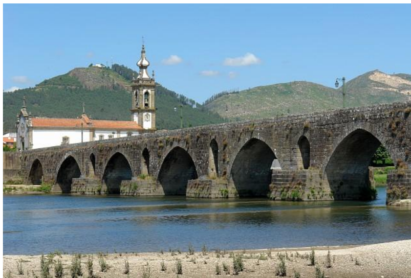
Figura 2.12 – Ponte em Ponte de Lima sobre o rio Lima [19]
