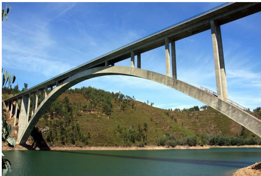
Figura 2.19 – Ponte sobre o rio Zêzere [28]
