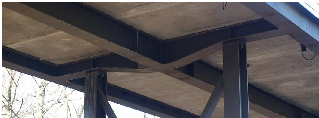
Figura 5.5 – Fotografia de pormenor das ligações entre os vários elementos metálicos
