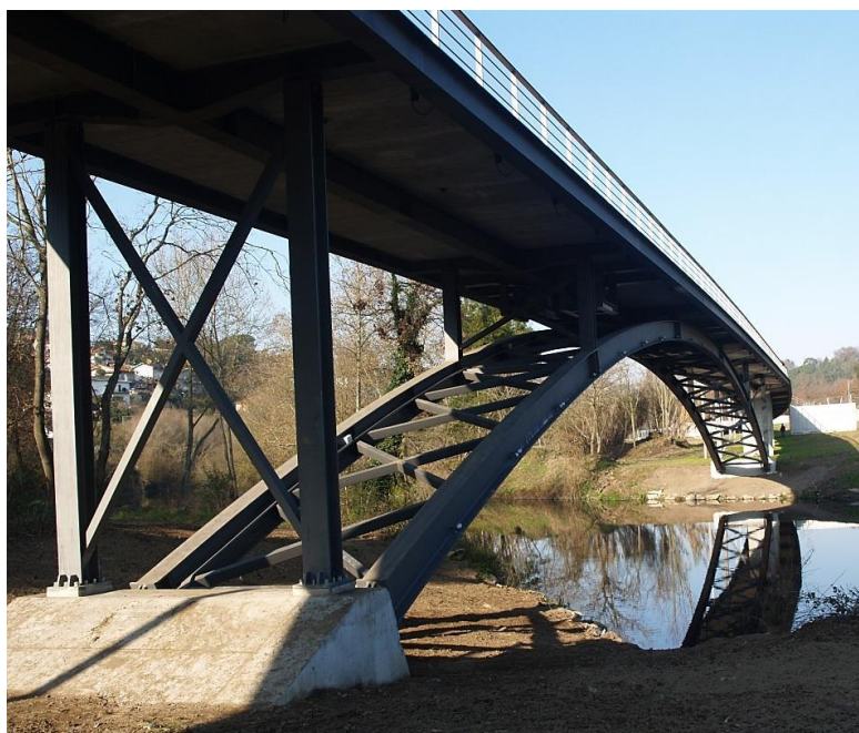
Figura 4.5 – Vista lateral da ponte
