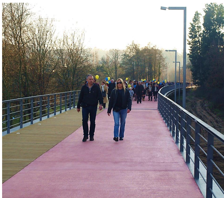
Figura 4.7 – Fotografia do tabuleiro da ponte
