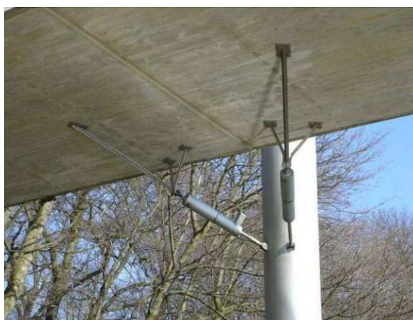
Figura 3.1 – Esquema de funcionamento de um amortecedor de fluido viscoso [3]
