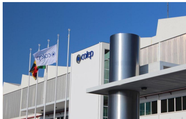
Figura 1 - Instalações de Vale de Cambra
