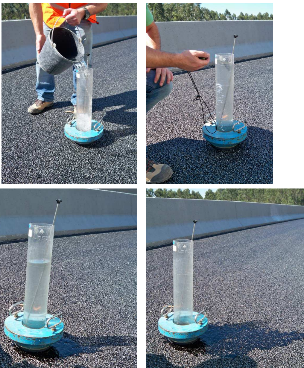
Fig. 56 – Metodologia do ensaio de permeabilidade "in situ" e especto final do caudal escoado sob o pavimento.
