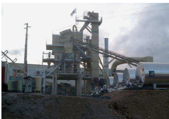
Fig. 26 – Central onde foi produzida a mistura betuminosa drenante.
