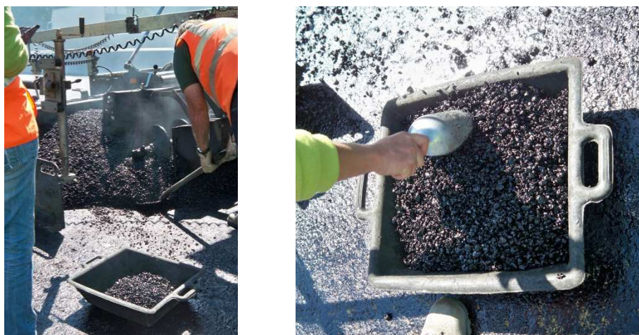
Fig. 32 – Recolha da mistura betuminosa em obra.
