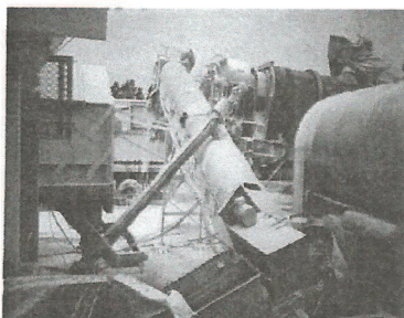
Incorporação de Asphacal H através de elevador a frio.
