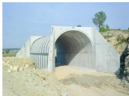
Fig. 2.12 - Exemplo de pré-fabricação pesada, passagem inferior
