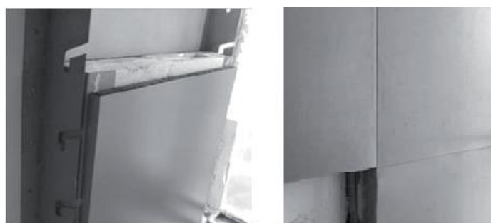
Fig. 2.36 - Modulo acabado e instalado
