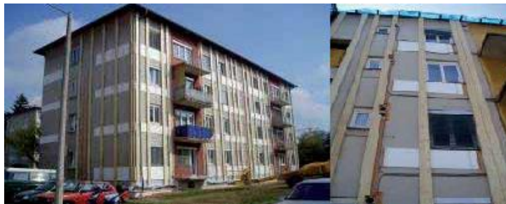
Fig. 2.22 - Subestrutura de madeira onde serão montados os módulos
