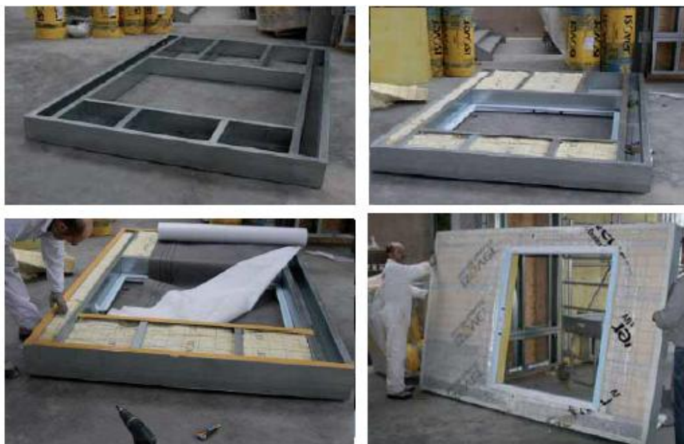
Fig. 2.28 - Montagem do módulo em fábrica
