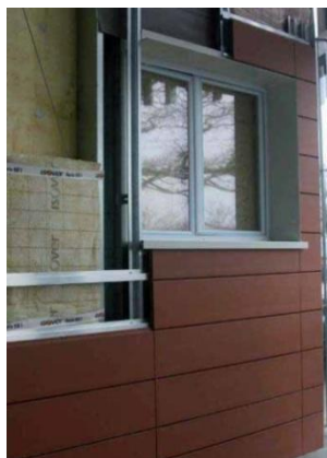
Fig. 2.29 - O acabamento do módulo é realizado em obra, neste caso uma fachada ventilada
