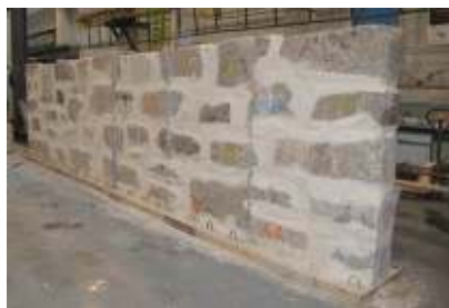
Fig. 3.3 – Parede de alvenaria de pedra irregular (IR), Almeida (2012).
