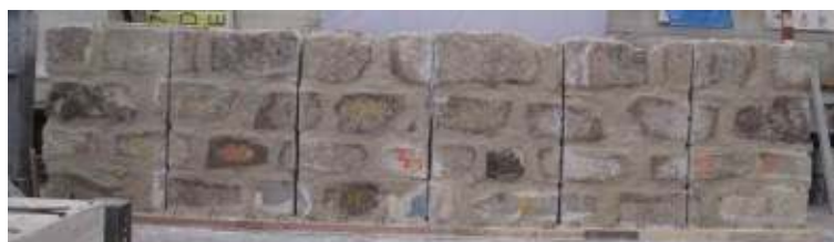
Fig. 3.2 – Parede de alvenaria de pedra parcialmente regular (PR), Almeida (2012).
