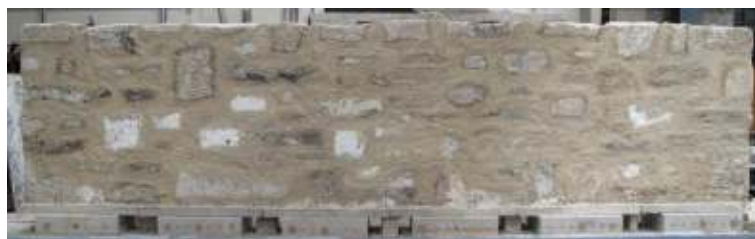
Fig. 3.4 – Parede de alvenaria de pedra muito irregular (IR++), Almeida (2012).
