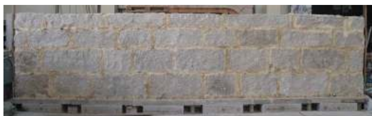
Fig. 3.7 – Pared de alvenaria de pedra com juntas preenchidas, Almeida (2012).
