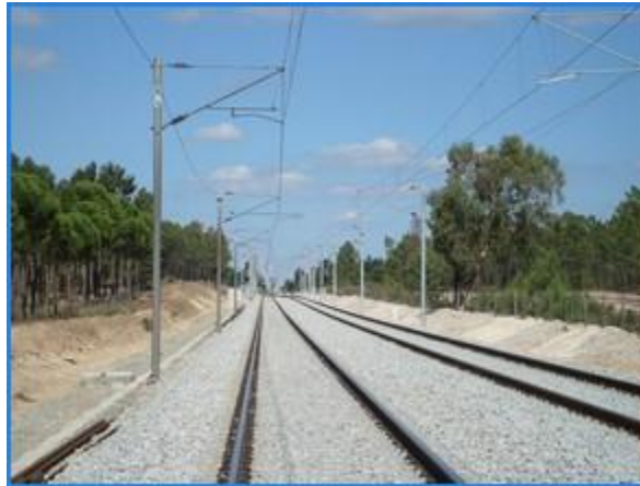
Figura 2.6 – Exemplo da camada de balastro (FERGRUPO, 2012).
