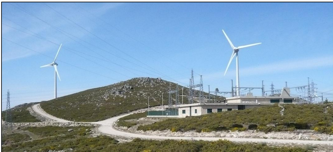
Fig. 5.1. Vista da subestação orientada a NW
