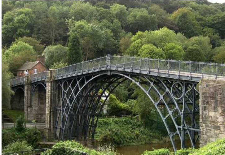
Figura 1.1 – Primeira aplicação de ferro em estruturas de engenharia civil[22]
