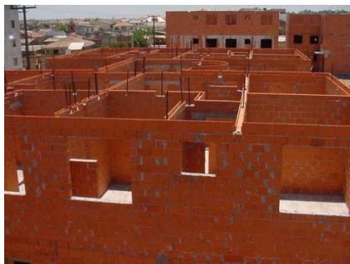
Figura 2 - Exemplo de estrutura em alvenaria simples
