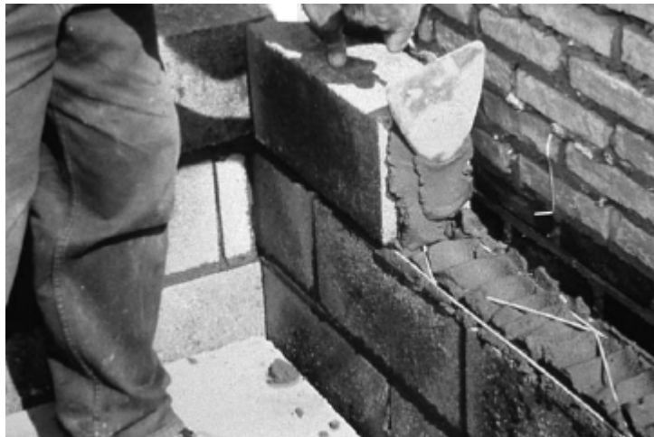
Figura 28 - Colocação de armadura de corte [10]
