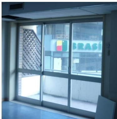
Figura 4.12 - Tipo de envidraçados que constituem a envolvente do edifício.
