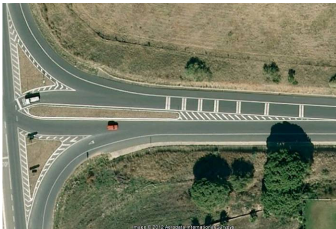
Figura 138 – Raias oblíquas M17 sem envolver a ilha separadora e raia oblíquas M17a envolvendo os ilhéus separadores – EN125 Algarve (Google Earth 2012)
