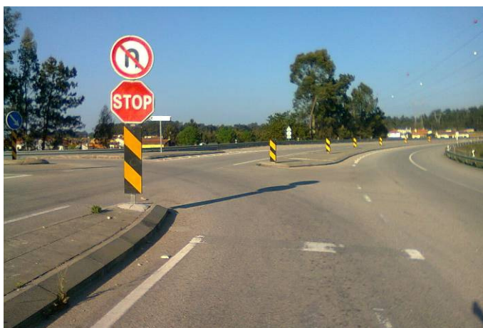
Figura 66 – Sinal C12 e sinal B2 utilizados incorretamente em viragem à esquerda a partir da via principal – Feira
