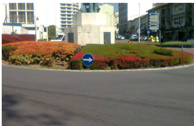
Figura 101 – Sinal D1a em rotunda com altura incorreta – S. João da Madeira
