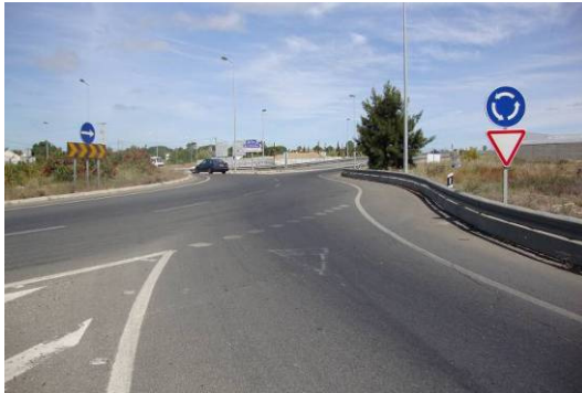
Figura 206 – Rotunda – M9a – LBTc – Linha de cedência de passagem com símbolo triangular
