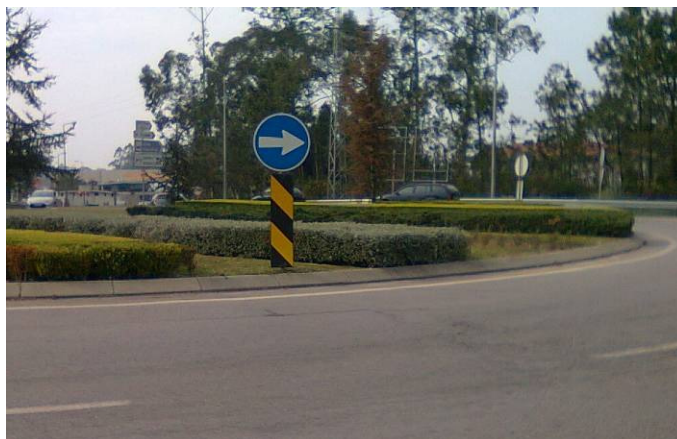
Figura 100 – Sinal D1a (anti regulamentar) incorretamente associado a baliza O7a – Vila do Conde
