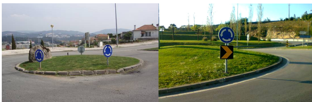
Figura 77 – Sinais D4 colocados incorretamente na ilha central – S. João da Madeira
