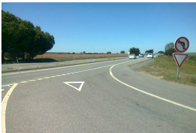
Figura 119 – Linha de cedência de passagem (M9a/LBTc) na viragem à direita da via secundária – IC1
