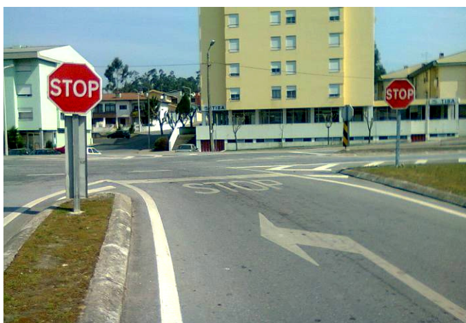
Figura 41 – Sinal B2 incorretamente repetido do lado esquerdo da faixa de rodagem – Feira
