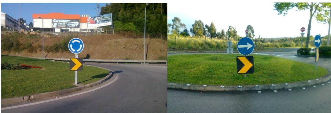
Figura 102 – Utilização incorreta de baias (O6a) na ilha central da rotunda – S. João da Madeira
