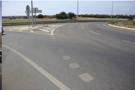
Figura 207 – Rotunda – M9a – LBTc – Linha de cedência de passagem com símbolo triangular apagado
