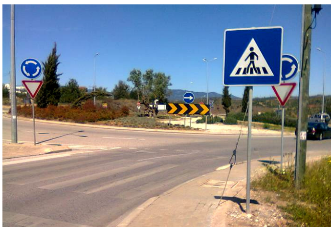
Figura 83 – Sinal de informação H7 que provoca redução de visibilidade aos sinais D4 e B1 associados – Portimão
