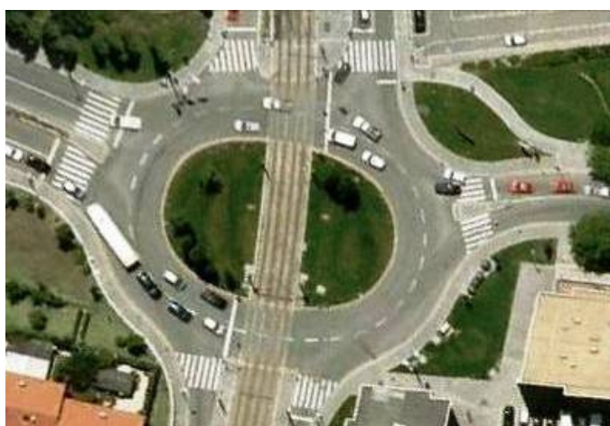
Figura 125 – Situação incorreta com travessias de peões junto ao anel de circulação – Porto (Google Earth 2012)
