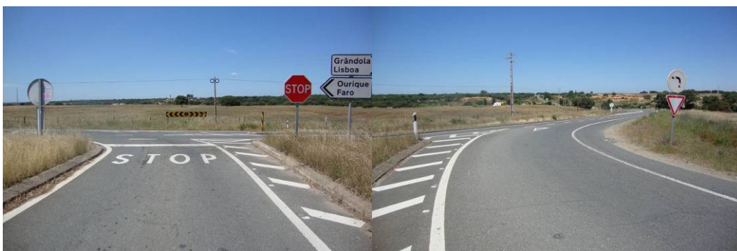
Figura 156 – Interseção prioritária – Sinal B2 – No lado direito
