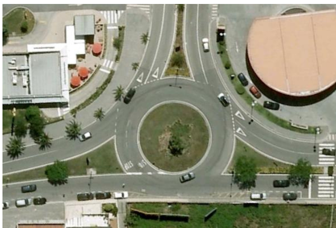
Figura 123 – Utilização incorreta de linha de paragem com inscrição “STOP” (M8a) no pavimento em rotunda – Porto (Google Earth 2012)
