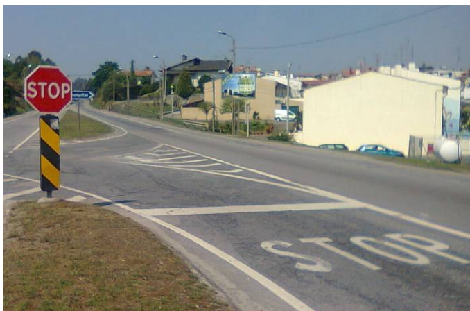
Figura 55 – Sinal B2 utilizado incorretamente na virgem à esquerda da partir da via principal – Feira
