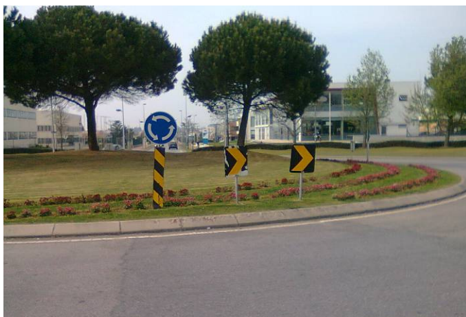
Figura 103 – Sinalização incorreta com baias (O6a), sinal D4 e baliza (O7a) na ilha central da rotunda – Vila do Conde
