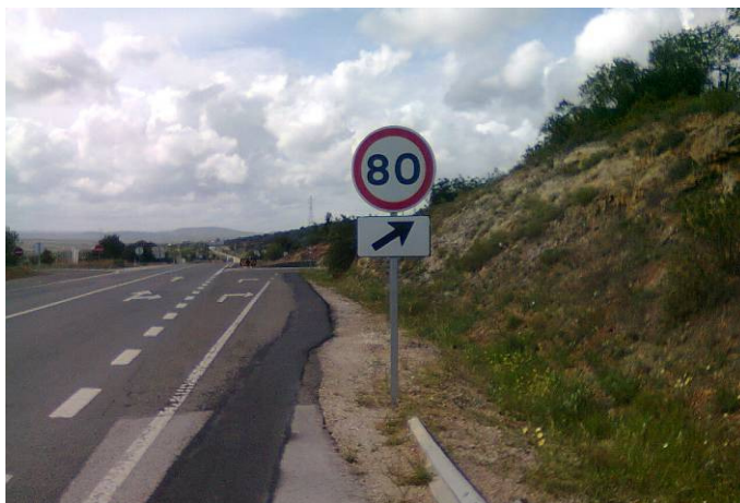
Figura 108 – Sinal de perigo A1a de curva à direita com painel adicional do modelo 17, incorretamente utilizado à saída da via de abrandamento numa interseção prioritária – Tunes
