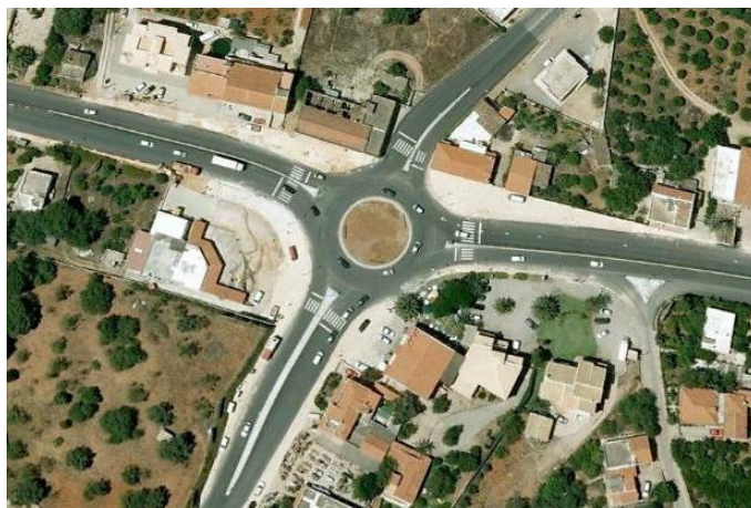
Figura 32 – “Cruzamento das 4 estradas” antiga interseção semaforizada com elevada sinistralidade, recentemente convertida em rotunda – EN125 – Algarve (Google Earth 2012)
