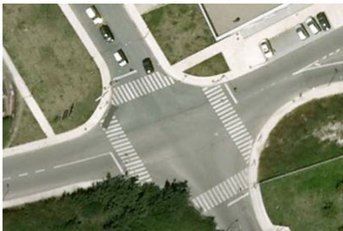
Figura 122 – Travessias de peões mal localizadas e sem perpendicularidade – Porto (Google Earth 2012)
