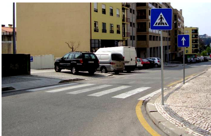
Figura 82 – Sinais de informação H7 e H3 colocados numa interseção de nível em meio urbano – S. João da Madeira
