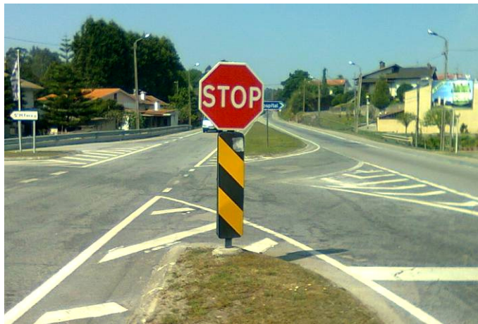
Figura 92 – Associação incorreta de baliza de posição O7a a sinal B2 (o sinal B2 está incorreto) – Feira
