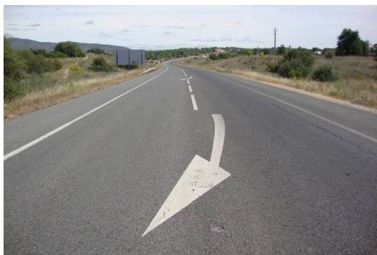
Figura 212 – Rotunda normal – Linha descontinua (M2/LBT) + Setas de desvio Tipo 2 + Linha descontinua de aviso (M4/LBTa) + Linha contínua (M1/LBC) – Na via secundária a aproximação da interseção
