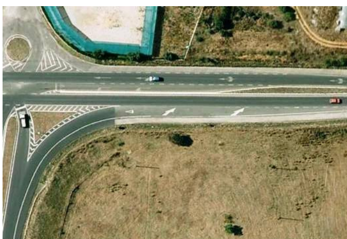
Figura 131 – Setas de desvio do Tipo 1/M16 incorretamente utilizadas em via de aceleração e apenas duas unidades – EN125 – Algarve (Google Earth 2012)
