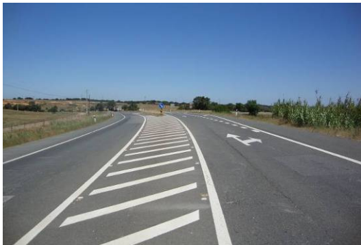
Figura 176 – Interseção prioritária – M17 – Raia oblíquas delimitadas por linha contínua Em alinhamento com o obstáculo, na via principal no sentido esquerda-direita
