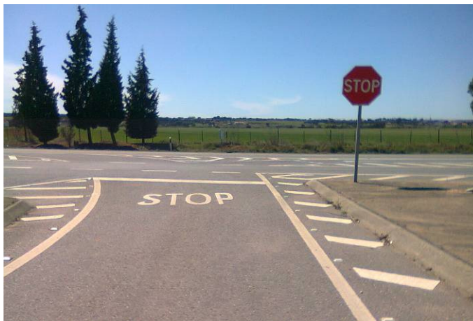
Figura 117 – Linha de paragem (M8a) na viragem à esquerda da via secundária – IC1
