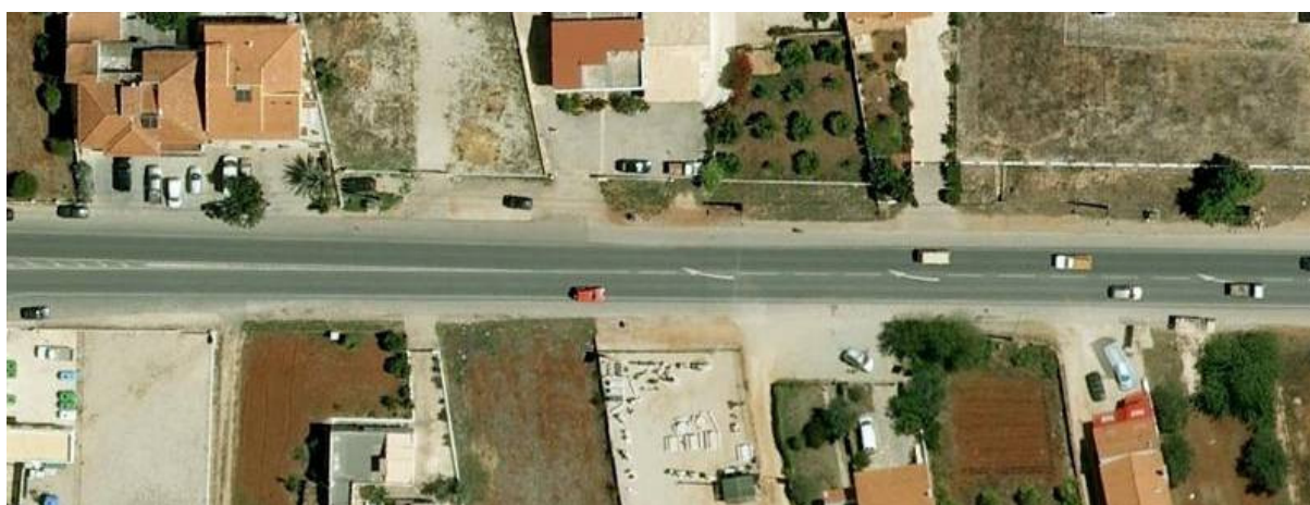
Figura 127 – Setas de desvio do Tipo 2/M16b a montante da interseção – EN125 – Algarve (Google Earth 2012)
