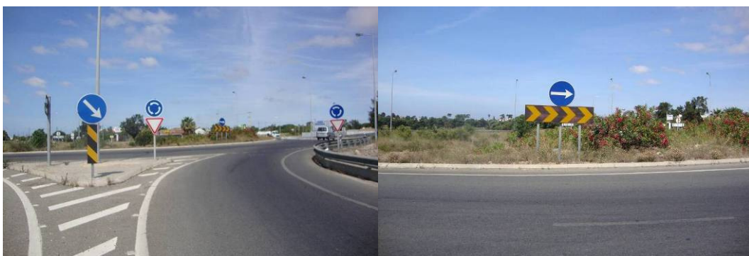
Figura 204 – Rotunda normal – Sinal D3a com a baia O7a – No extremo da ilha separadora na aproximação da interseção e Sinal D4 e Sinal B1 – Repetido do lado esquerdo
