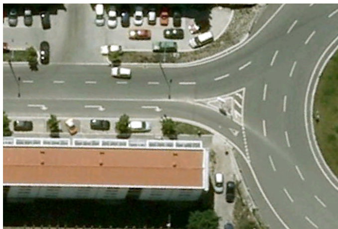
Figura 134 – Setas de seleção M15b simples à direita, incorretamente utilizadas em via única de acesso a rotunda – Porto (Google Earth 2012)
