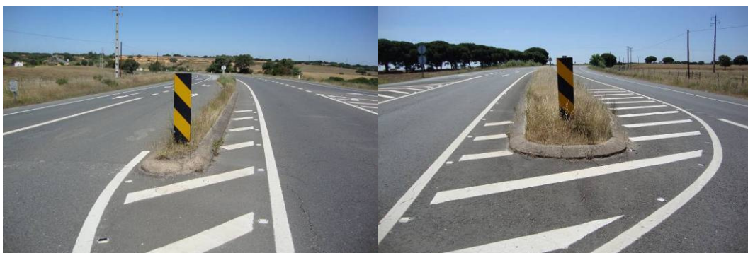
Figura 158 – Interseção prioritária – O7a – no extremo da ilha separadora em sentido contrário ao acesso
