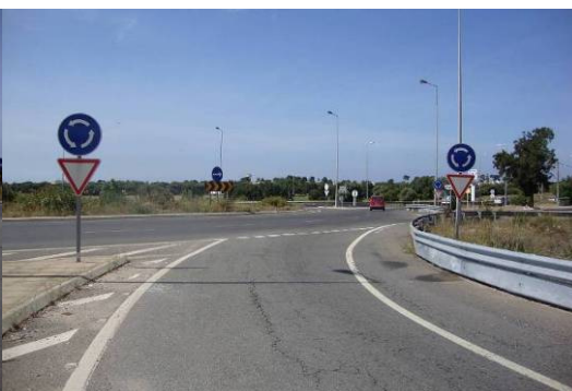
Figura 192 – Rotunda normal – Sinal D4 e Sinal B1 – Repetido do lado esquerdo D1a e Baia O6b (simples) – orientado para a via secundária
