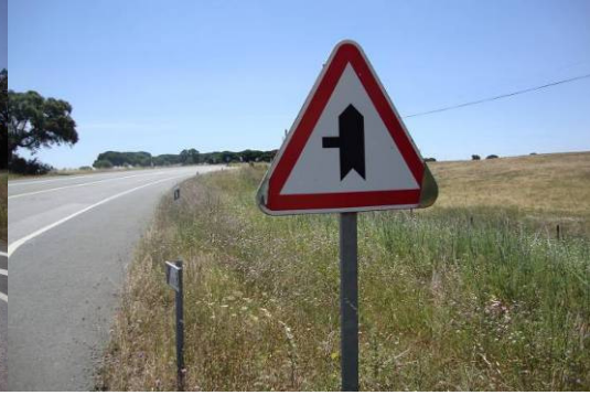
Figura 165 – Interseção prioritária – Sinal B9a – Isolado do lado direito
