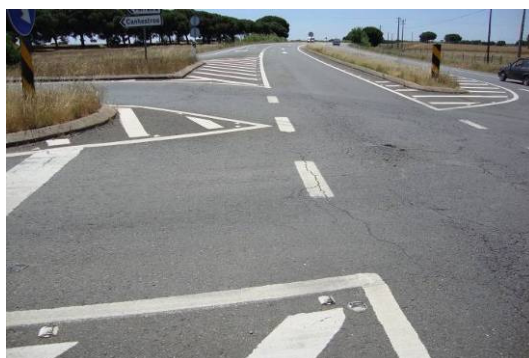
Figura 173 – Interseção prioritária – (LBTg) Linhas descontinuas de guiamento, na zona das viragens
