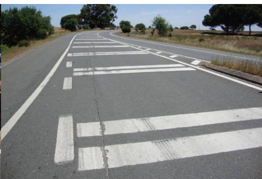
Figura 181 – Interseção prioritária – M20 – Bandas cromáticas – Na via secundária na aproximação à interseção
