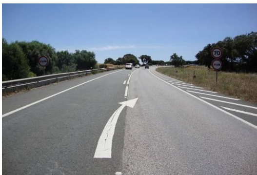
Figura 178 – Interseção prioritária – Linha descontinua (M2/LBT) + Setas de desvio Tipo 2 + Linha descontinua de aviso (M4/LBTa) + Linha contínua (M1/LBC) – Na via principal na aproximação no sentido direita-esquerda
