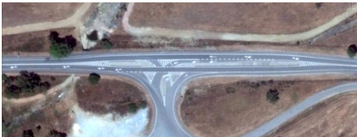
Figura 9 – Interseção prioritária de 3 ramos em “T” com movimentos canalizados – IC1 – Grândola (Google Earth 2012)
