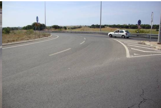
Figura 209 – Rotunda normal – Linha descontínua (M2/LBT) e guias no anel de circulação
