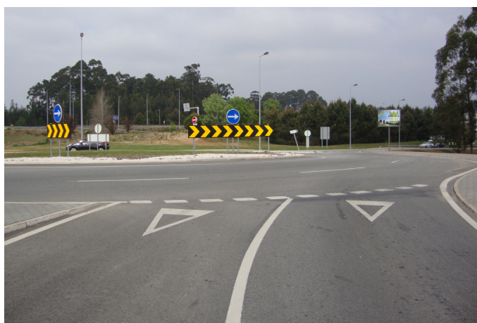
Figura 96 – Baias direcionais múltiplas (O6b) lado a lado e sinal D1a em via dupla – Feira
