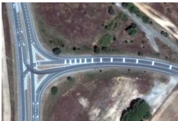
Figura 137 – Bandas cromáticas em situação de paragem – IC1 (Google Earth 2012)
