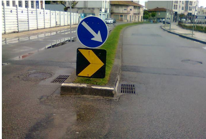
Figura 87 – Utilização incorreta de baia O6a no topo de ilha separadora – S. João da Madeira
