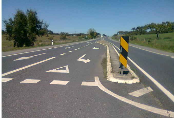
Figura 91 – Baliza de posição O7a em sentido contrário ao acesso à interseção – IC1
