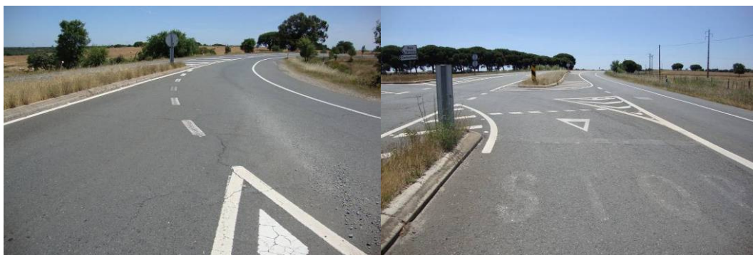
Figura 171 – Interseção prioritária – M9 – LBTc – Linha de cedência de passagem (opcional) – Na interseção da viragem à direita, com a viragem à esquerda a partir da principal (regulada pela regra da prioridade à direita)
