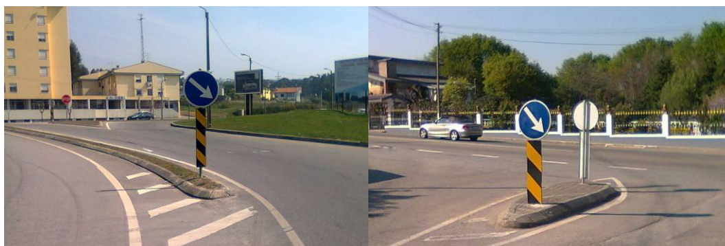
Figura 76 – Sinalização correta num dos topos da ilha separadora e incorreta no outro – Avintes
