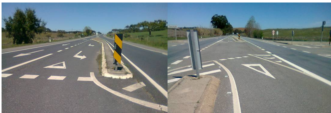
Figura 120 – Linha de cedência de passagem (M9a/LBTc) na via de abrandamento da viragem à esquerda – IC1
