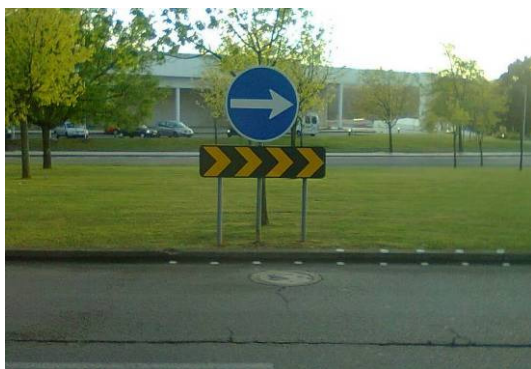
Figura 38 – Sinal D1a de dimensão grande incorretamente combinado com baia (O6b) de dimensão reduzida – S. João da Madeira
