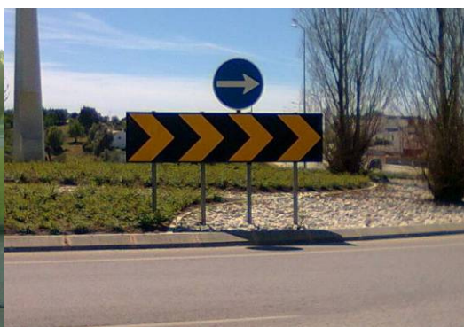
Figura 39 – Sinal D1a de dimensão normal 70cm incorretamente combinado com baia (O6b) de dimensão grande – Portimão
