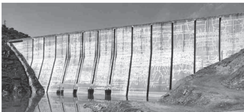
Figura 2.13 – Paramento de montante da barragem da Pracana [38].
