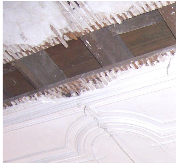
Figura 3.20. – Revestimento e acabamento de teto: a) forro; b) fasquios e acabamento em estuque [Queirós, 2010]
