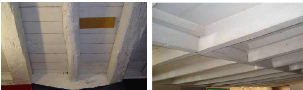
Figura 3.10. – Vigas: a) com topos alternados [Ilharco et al, 2007]; b) esquadriadas [Ilharco et al, 2006]
