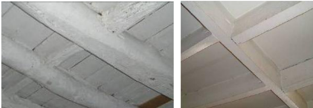
Figura 3.14. – Tarugamento: a) em vigas de secção circular [Iharco et al , 2007]; b) em vigas de secção retangular [Iharco et al , 2006]
