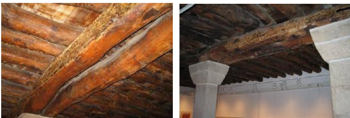
Figura 3.13. – Diminuição do vão das vigas com vigas transversais [Dias, 2008]
