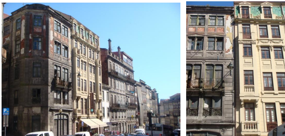
Figura 3.8. – Rua Mouzinho da Silveira no Porto: à esquerda uma vista geral do edificado; à direita a diferença entre um prédio reabilitado e um por reabilitar [Correia, 2009]
