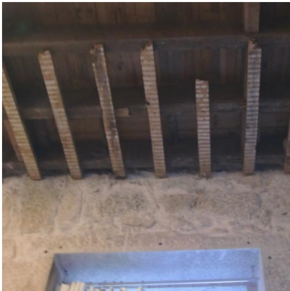
Figura 3.20. – Revestimento e acabamento de teto: a) forro; b) fasquios e acabamento em estuque [Queirós, 2010]
