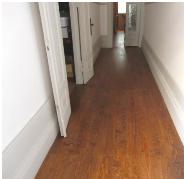
Figura 3.18. – Pavimento estrutural com revestimento superior em soalho [Queirós, 2011]
