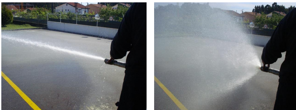
Figura 5.7 – Teste da rede de incêndio armada.
