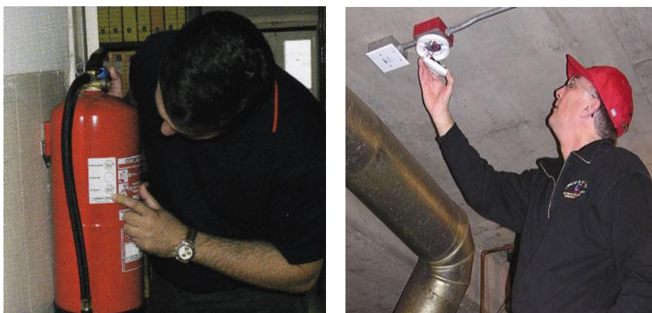
Figura 3.5 – Inspeção de equipamentos de SCIE, [11].
