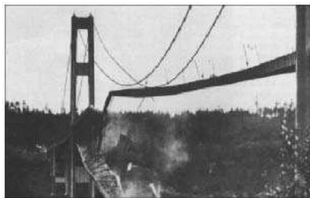
Figura 1.1: Ponte de Tacoma Narrows em vibração induzida pelo vento
