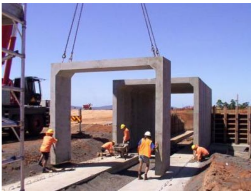
Fig. 3 6 - Instalação de Box-Culvert [24]
