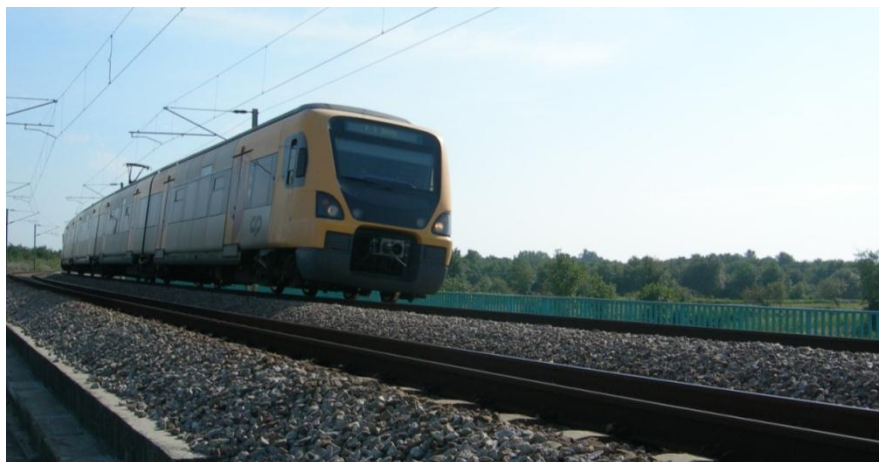
Figura 4.7 – Observação do desnível entre carris da mesma via devido à curvatura em planta
