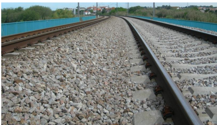
Figura 4.10 – Observação da variação da altura da camada de balastro
