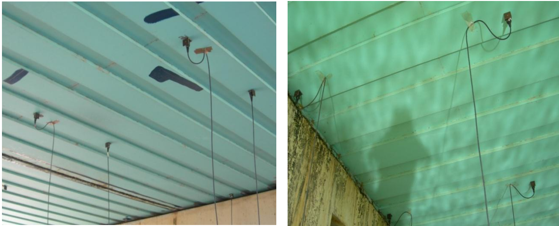
Figura 4.15 – Colocação dos acelerômetros à face inferior das vigas metálicas
