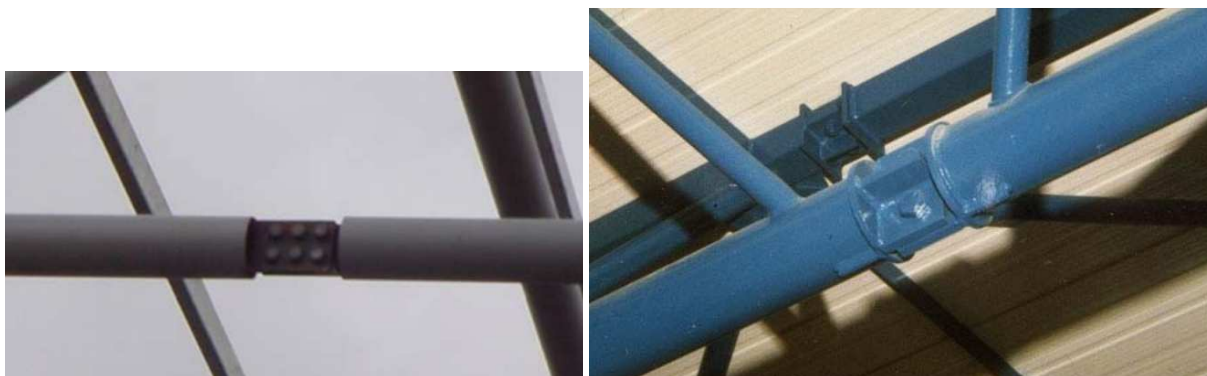
Figura 2.2 – a): Ligação tubo-gousset em emendas (Fonte: CORUSTUBES, 2006)
