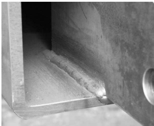
Figura 2.24 – Chapa dentro do tubo: detalhe de cordões de soldadura. (Fonte: Willibald, 2003)
