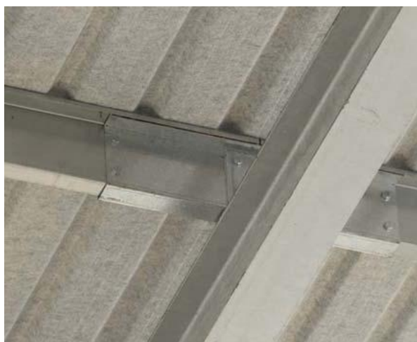
Fig. 2.12 – Exemplo de aplicação de forro anti condensação.
