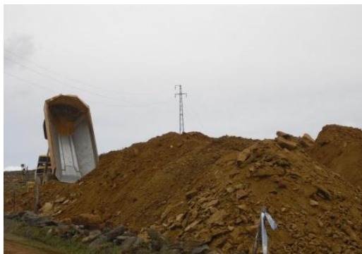
Figura 5.5 - Movimentação de terras em obra
