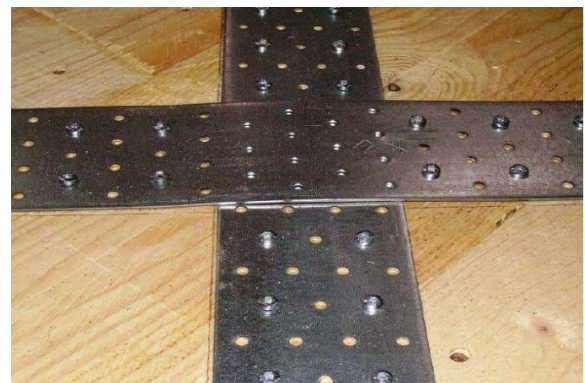
Figura 4.68 e 4.69 À esquerda, esquema de ensaio de pavimento reforçado com chapas de aço na face superior; À direita, pormenor da ligação entre chapas de aço através de parafusos de porca (Baldessari;2010)
