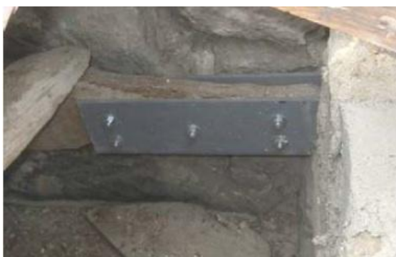
Figura 4.6 e 4.7 Pormenores do encontro da viga de madeira reforçada com a parede de alvenaria (Ilharco et al.:2010)
