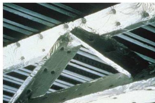
Figura 4. 84 e Figura 4. 85 Figura 5.85 e 5.86 À esquerda, exemplo de aplicação de placa de gesso cartonado (Pannoni;2001); À direita, aplicação de placa de lã de rocha
