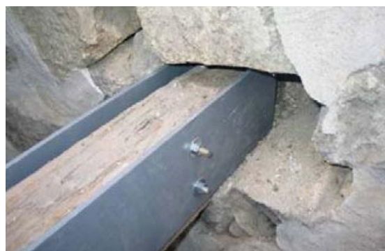
Figura 4.6 e 4.7 Pormenores do encontro da viga de madeira reforçada com a parede de alvenaria (Ilharco et al.:2010)
