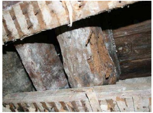
Figura 3.6 Exemplo de dano causado por caruncho na madeira (Guedes; Ilharco et al.;2012)
