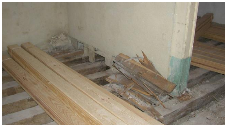
Figura 3.10 Introdução de paredes de compartimentação sobre o pavimento (Cruz;2011)
