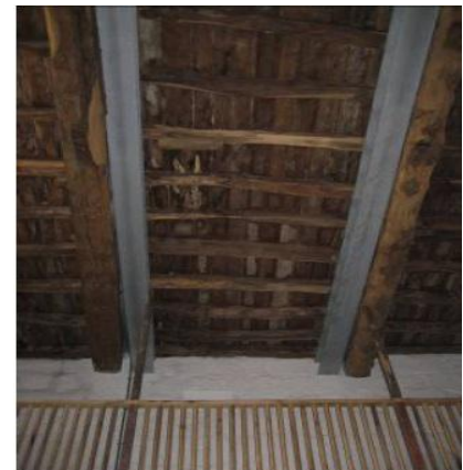
Figura 4.74 e 4.75 Exemplo de aplicação de vigas metálicas paralelas ao vigamento existente (Ilharco et al.;2010a)
