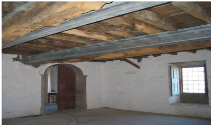
Figura 4.74 e 4.75 Exemplo de aplicação de vigas metálicas paralelas ao vigamento existente (Ilharco et al.;2010a)
