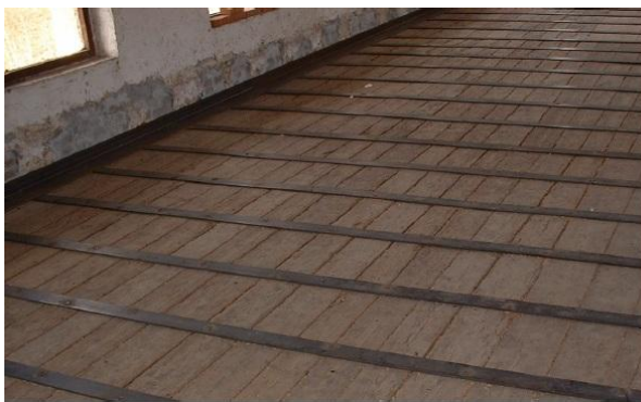
Figura 4.53 e 4.54 À esquerda, exemplo prático de aplicação desta solução num pavimento em madeira; À direita, corte transversal de viga de madeira com chapa metálica na face superior, ligada por parafuso de porcas (Pinto;2008)
