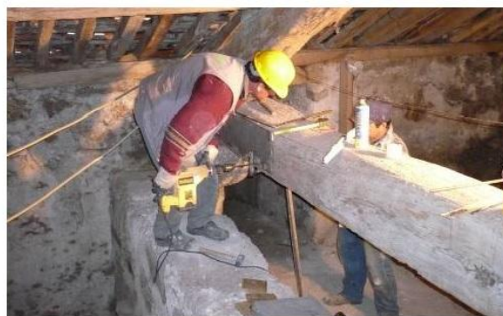
Figura 4.11 e 4.12 À esquerda, esquema da reabilitação realizada; À direita, pormenor da execução da introdução dos varões roscados e das chapas metálicas (Ilharco et al;2010 b)
