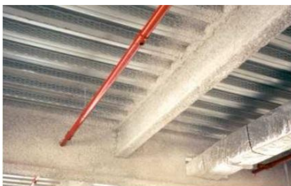
Figura 4. 82 e 4. 83 À esquerda, exemplo de aplicação de argamassa projetada; À direita, exemplo de aplicação de fibras projetadas (Pannoni;2001)
