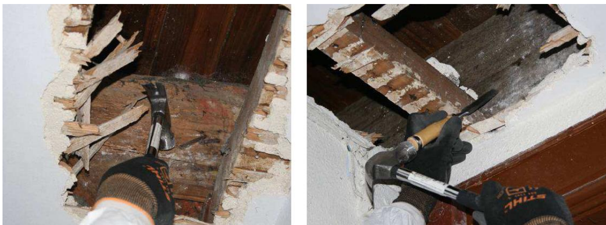
Figura 3.15 e 3.16 À esquerda, exemplo de utilização de martelo na avaliação de danos; À direita, exemplo de uso de um formão – Escarificação (Guedes; Ilharco et al.;2012)
