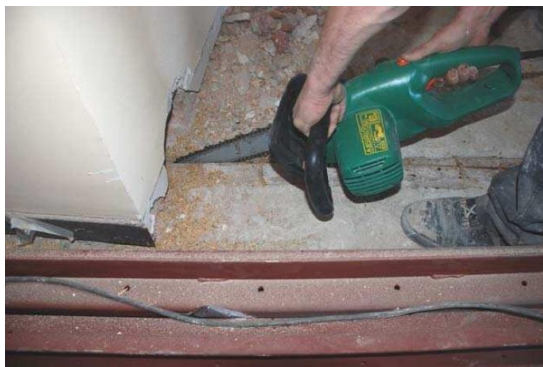
Figura 4.81 Realização de abertura através de moto-serra na face superior de viga de madeira (González-Bravo;2007)
