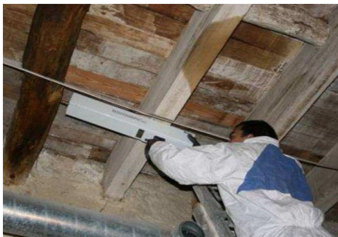
Figura 3. 17 Exemplo de aplicação de resistógrafo em viga de pavimento (Guedes; Ilharco et al.;2012)
