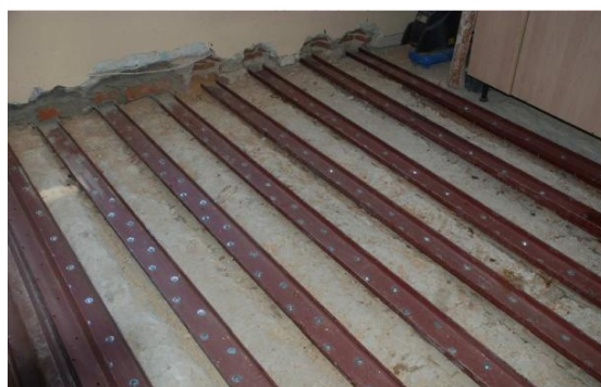
Figura 4.62 e 4.63 À esquerda, exemplo de colocação em obra de ligadores metálicos (González-Bravo;2007); À direita, resultado final de colocação em obra de perfil metálico na face superior de vigas de madeira (González-Bravo;2007)
