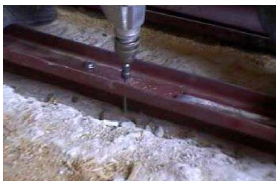
Figura 4.62 e 4.63 À esquerda, exemplo de colocação em obra de ligadores metálicos (González-Bravo;2007); À direita, resultado final de colocação em obra de perfil metálico na face superior de vigas de madeira (González-Bravo;2007)
