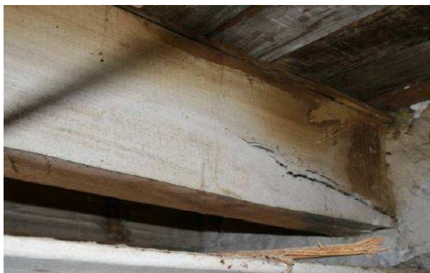
Figura 3.2 Fenda de secagem longitudinal (Guedes; Ilharco et al.;2012)
