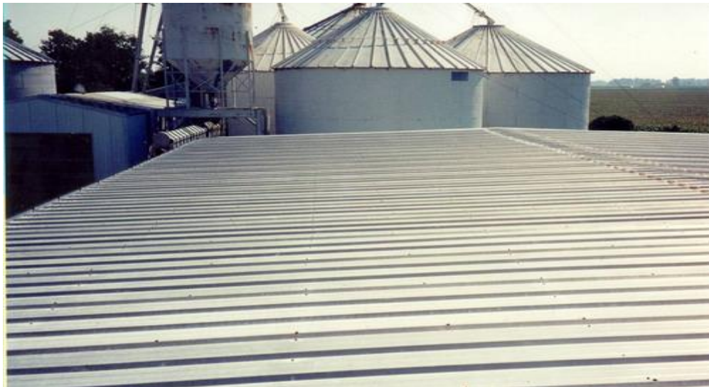
Fig 2.1 - Cobertura Metálica Plana [1].
