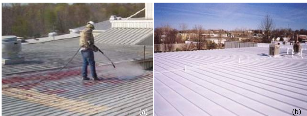
Fig 5.11 – (a) Preparação da superfície antes da aplicação da proteção. (b) Aspeto da superfície do revestimento após a aplicação da proteção [54]
