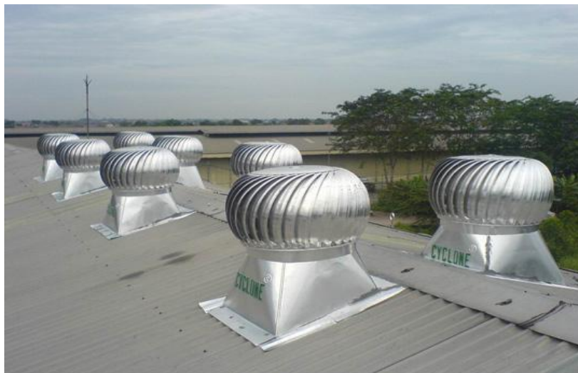
Fig 3.2 – Sistema de ventilação mecânica de uma cobertura [29].
