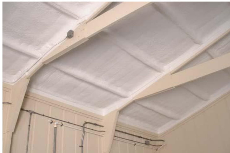
Fig 5.6 – Aspeto final de uma aplicação de SPF pelo interior do revestimento [20]
