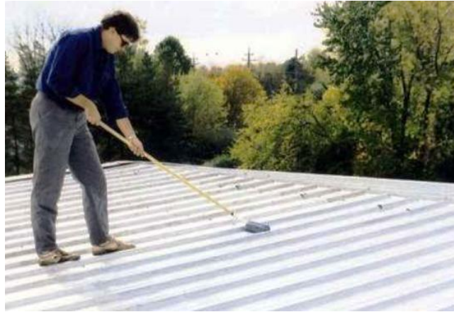
Fig 5.7 – Escovagem manual de um revestimento metálico [51]
