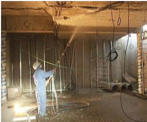
Fig 5.3 – Projeção de flocage na cobertura [20]
