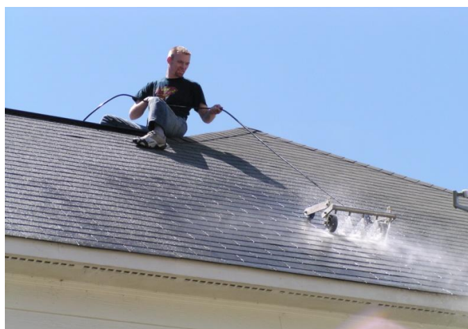
Fig 5.8 – Aplicação da técnica de limpeza a jato de água num revestimento [52]
