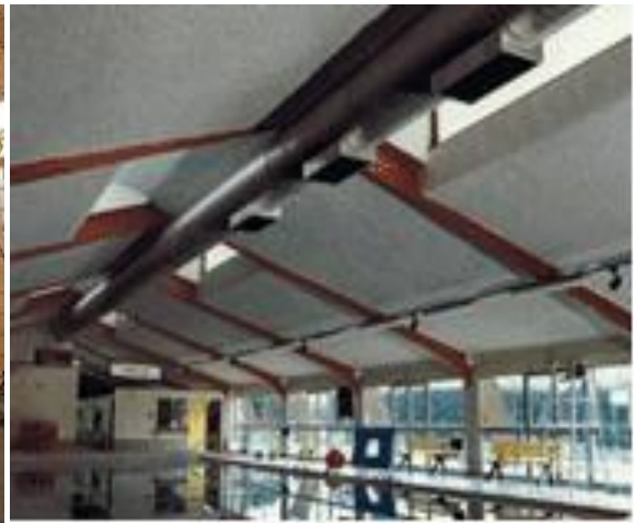
Fig 5.4 – Flocage aplicado na cobertura de uma nave de piscinas [20]
