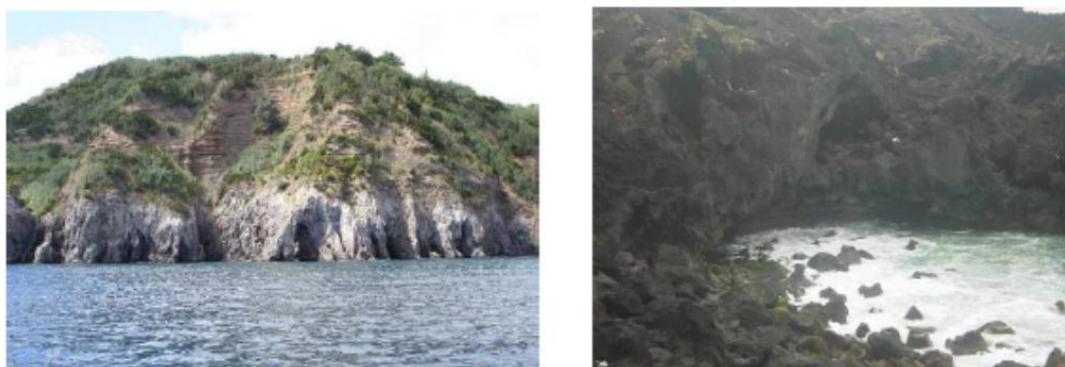
Fig. 3.31 – Arriba junto à Água d'Alto e pormenor de erosão na base (POOC São Miguel, Costa Sul).
