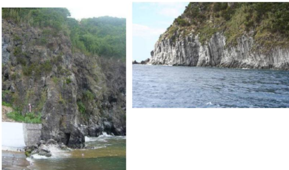
Fig. 3.34 – Aspeto da arriba na Caloura e da arriba a ocidente do Faial da Terra (POOC São Miguel, Costa Sul).
