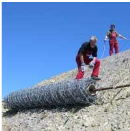
Fig. 4.21 - Montagem da malha (GEOBRUGG).
