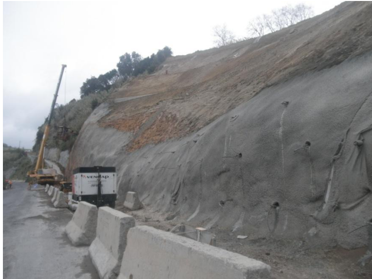
Fig. 4.23 – Pregagens e betão projetado em arribas na Ilha de S. Miguel, Açores.
