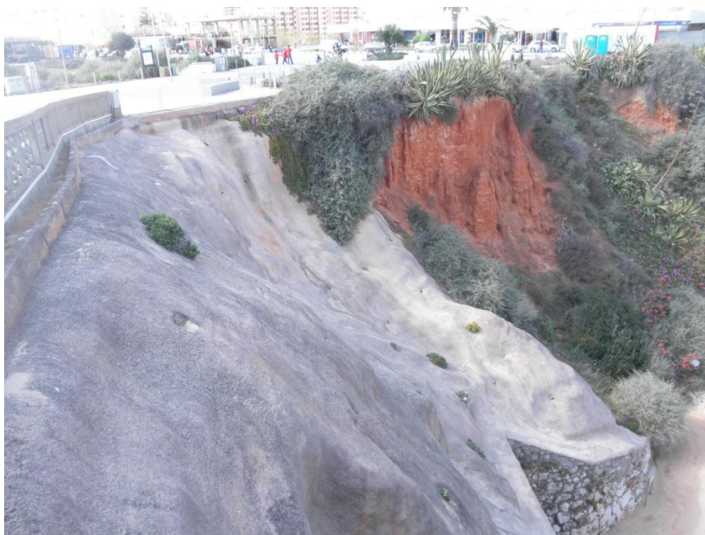
Fig. 4. 28 - Praia da Rocha (Algarve). Proteção da arriba com betão projetado e muro no pé do talude.
