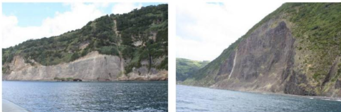
Fig. 3.33 – Aspeto da arriba junto à Ponta da Graça e aspeto da arriba a oriente do Faial da Terra (POOC São Miguel, Costa Sul).
