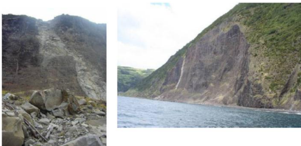
Fig. 3.43 – Deslizamento na arriba (Faial da Terra – Fajã do Calhau) (POOC São Miguel, Costa Sul).
