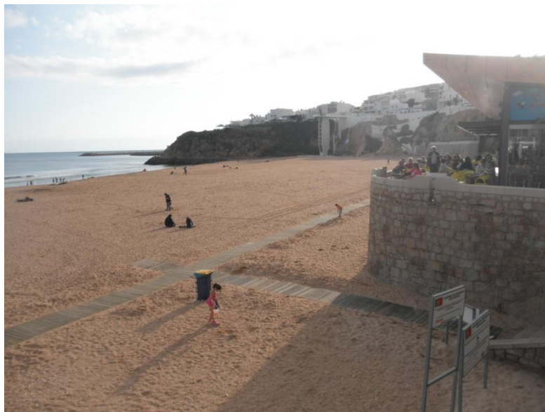
Fig. 4.11 - Praia de Albufeira ponte (Algarve). Areal resultante da alimentação artificial com areias para proteção das arribas e aumento da área balnear.
