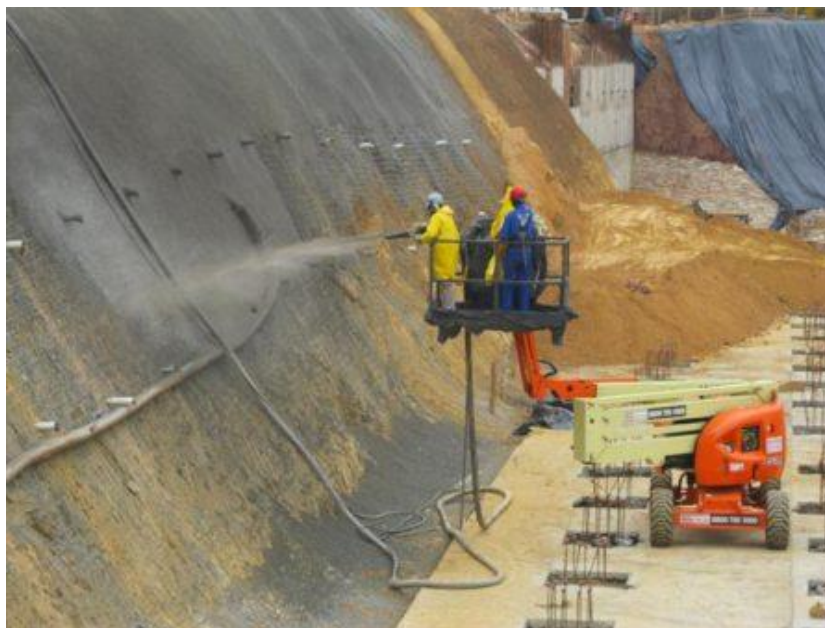
Fig. 4.25 – Técnica de betão projetado
