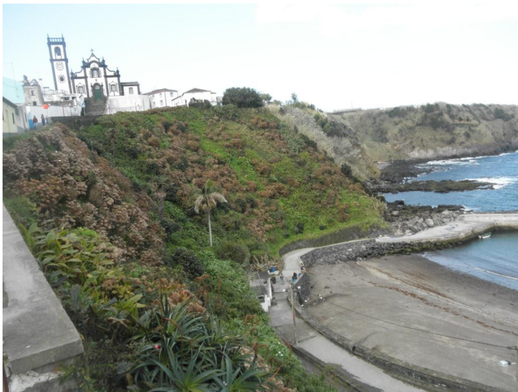
Fig. 4.27 – Proteção no pé da arriba de Porto Formoso, S. Miguel, Açores.
