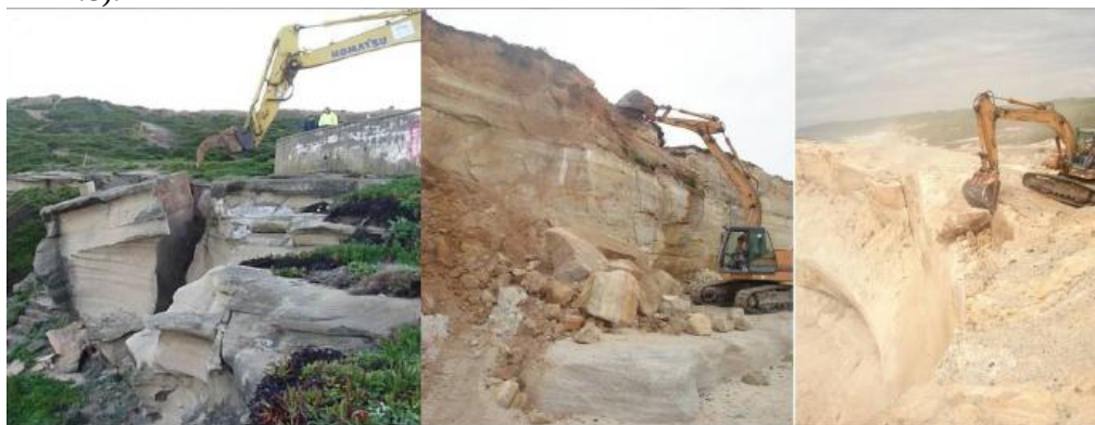
Fig. 4.8 – Medidas de minimização do risco de queda de blocos
