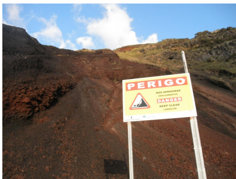
Fig. 4.6 – Sinalização de perigo de instabilidade de massa na praia da Ferraria em S. Miguel, Açores.
