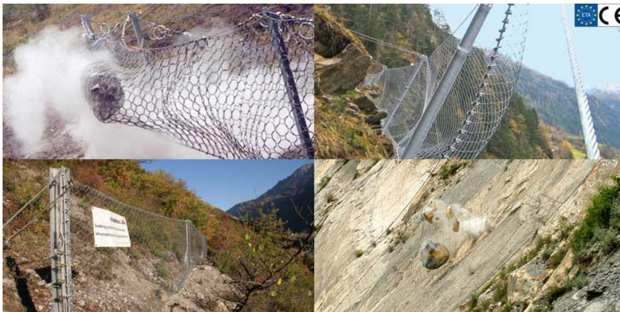
Fig. 4.19 – Diversos tipos de proteção contra a queda de rochas (GEOBRUGG).
