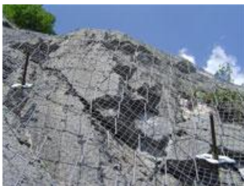
Fig. 4.22 – Sistema de proteção de taludes (GEOBRUGG).
