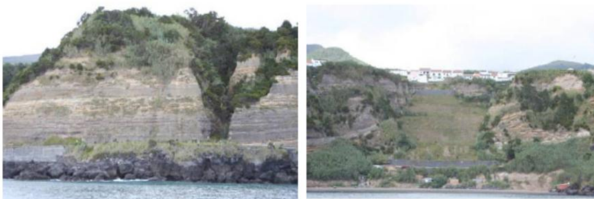
Fig. 3.40 – Arriba em Água d'Alto e pressão urbanística em zona instável (POOC São Miguel, Costa Sul).
