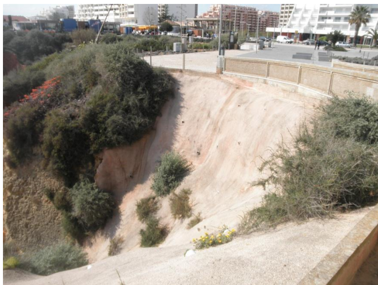
Fig. 4.24 - Praia dos Três Castelos (Algarve). Proteção da arriba com betão projetado.
