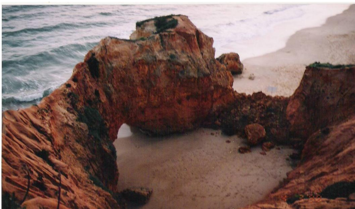
Fig. 3.20 – Colapso no extremo este da praia Maria Luísa em 28 março de 2008 (Teixeira, 2009).
