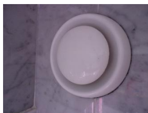
Figura 48 Bocal de extração no sistema de extração centralizada
