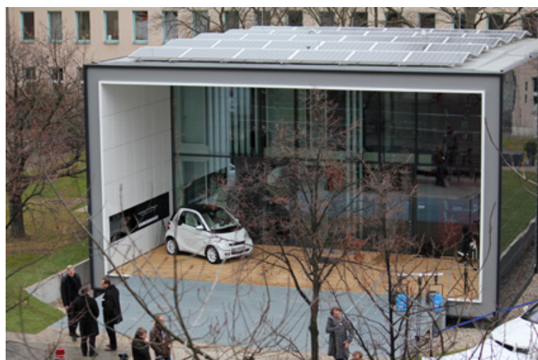
Fig. 4.26 – Painéis Fotovoltaicos na Cobertura da Casa [85].
