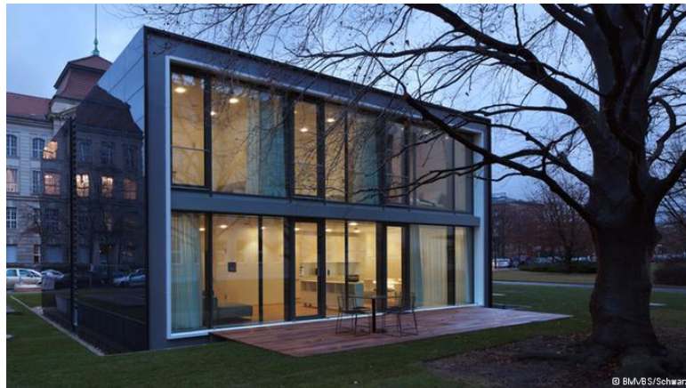
Fig. 4.14 – Fachada Este da Casa (Traseiras) [85].
