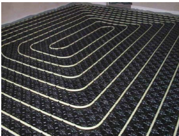
Fig. 2.61 – Piso Radiante [48].
