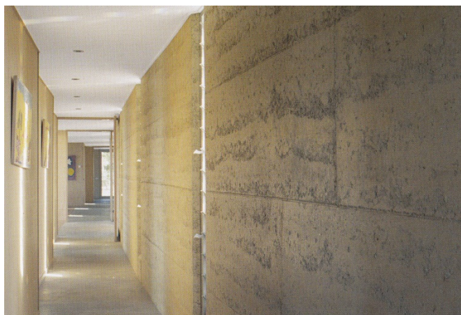
Fig. 2.14 - Parede de taipa [14].
