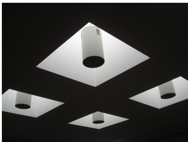
Fig. 2.45 – Claraboias. Secção de Construções, DEC [Foto do Autor].
