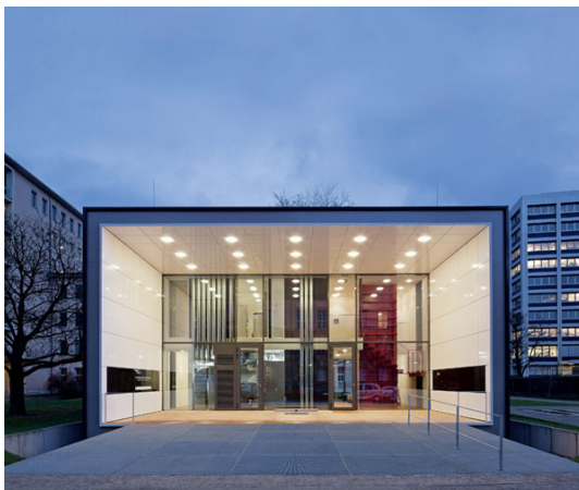
Fig. 4.13 – Fachada Oeste da Casa (Entrada) [85].
