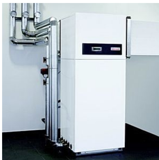
Fig. 4.23 – Bomba de Ar-Água-Calor utilizada na casa [88]
