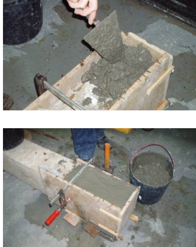
Figura 3: Tratamento das zonas danificadas da viga
