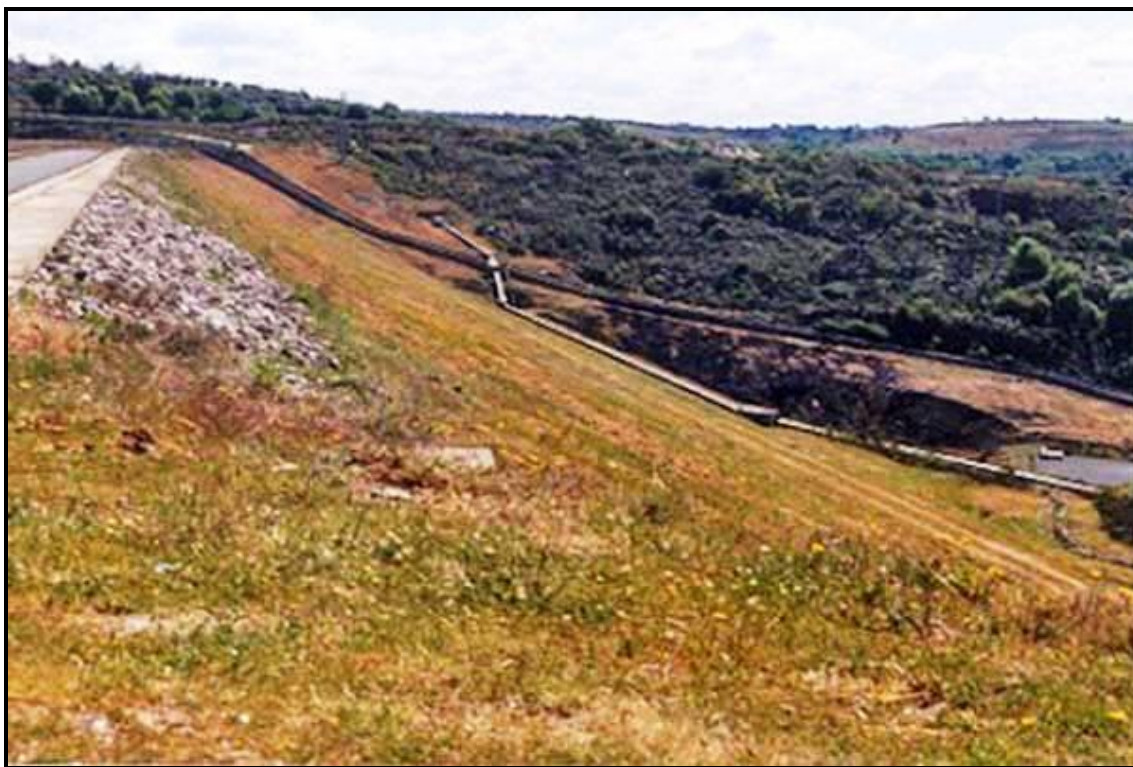
Figura 16. A barragem do Azibo construída em terra batida. (Fonte: CNPGB, 1992).
