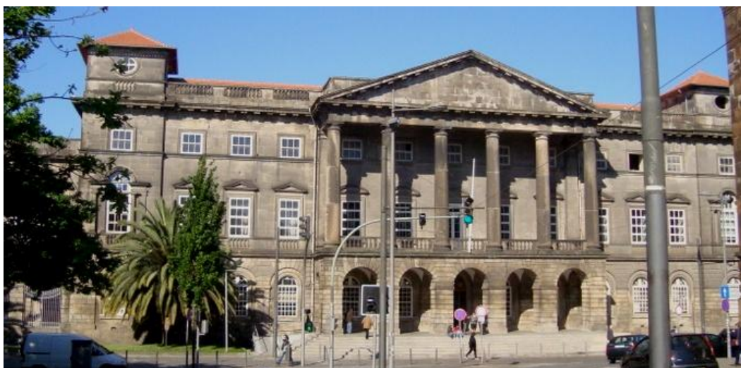
Estampa XCIII – Hospital de Santo António. Corpo central da fachada voltada a nascente.
