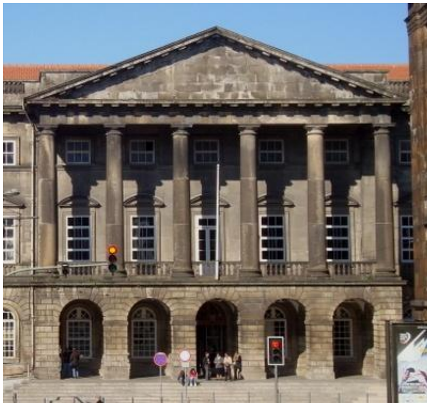
Estampa XCIV – Hospital de Santo António. Fachada voltada a nascente. Pórtico hexastilo do corpo central.
