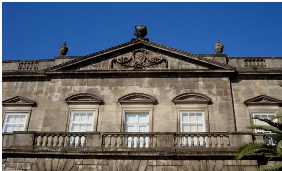
Estampa XCVI – Hospital de Santo António. Fachada voltada a nascente. Pormenor do corpo central do corpo intermédio (frontão e andar nobre).
