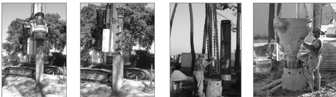
Figura 6. Execução das estacas moldadas com recurso a tubo moldador (Fundações Especiais da Mota-Engil, SA).
