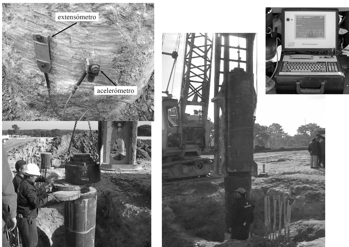
Figura 24. Ensaios dinâmicos das estacas de reacção – Santo Estevão (Gouveia Pereira, 2003)
