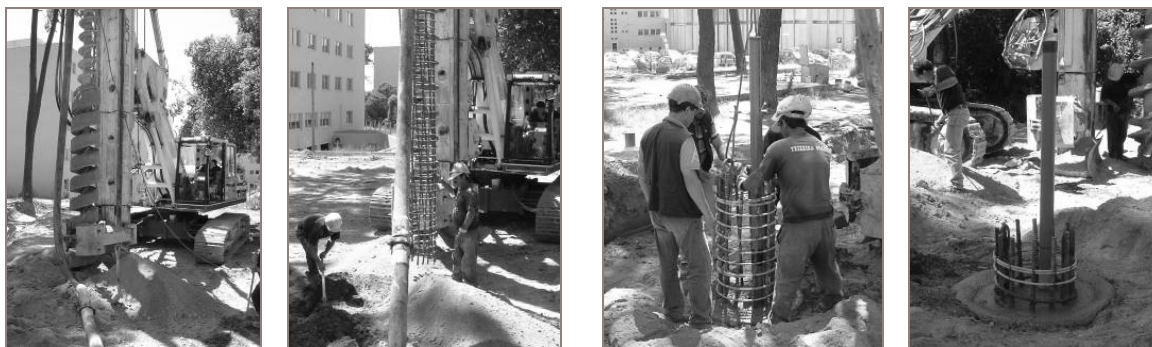
Figura 7. Execução das estacas moldadas com recurso à técnica do trado contínuo (Teixeira Duarte, Engenharia e Construção, SA).
