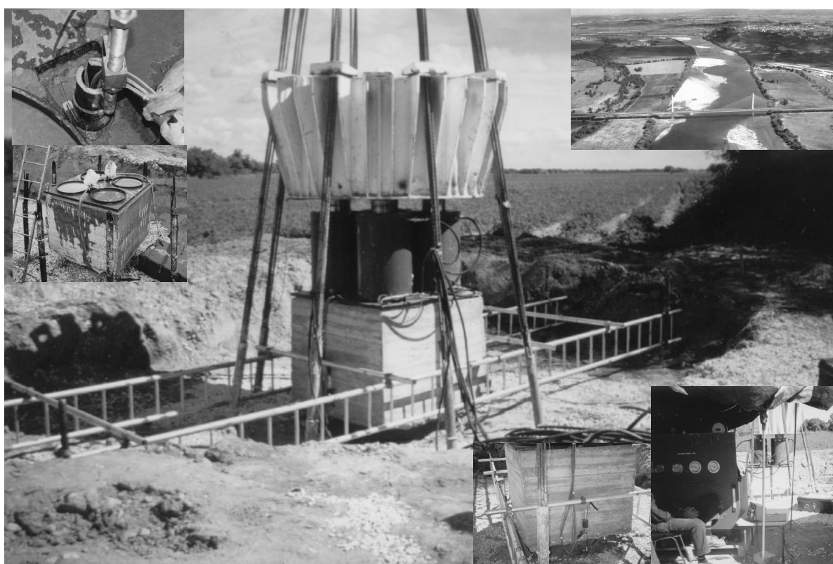
Figura 17. Ensaios de estacas na Ponte sobre o Tejo em Santarém (Salgueiro-Maia).
