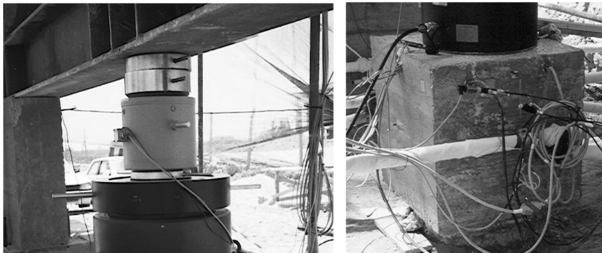
Figura 14. Ensaio de estacas no Pavilhão de Portugal-EXPO'98: a) Sistema de aplicação, medição e centragem das forças; b) Transdutor de pressão intercalado no circuito de óleo (LNEC, 1996).
