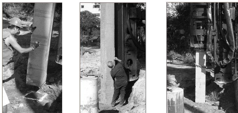
Figura 8. Execução das estacas pré-fabricadas cravadas (Sopecate, SA).
