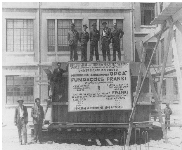
Figura 1. Ensaio de estaca-pilar no Pavilhão das Oficinas e Laboratório da FEUP, Anos 30 (Lousada Soares, 1992).
