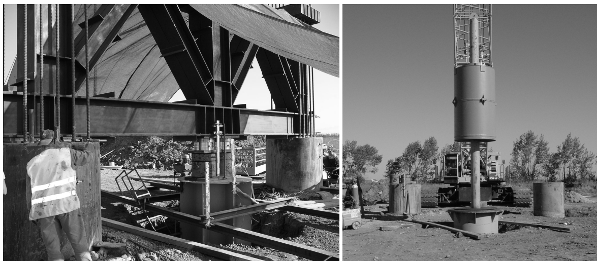
Figura 32. Ensaios estáticos e dinâmicos em estacas na Nova Travessia do Tejo no Carregado.
