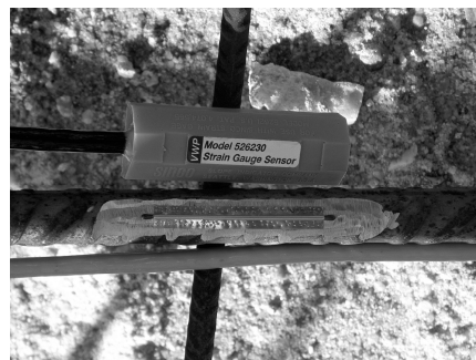
Figura 22. Extensómetros eléctrico e de corda vibrante soldados a um varão da armadura (IP6, Viadutos sobre os rios Galvão e Real. A2P/IEP/Tecnasol, 2005).
