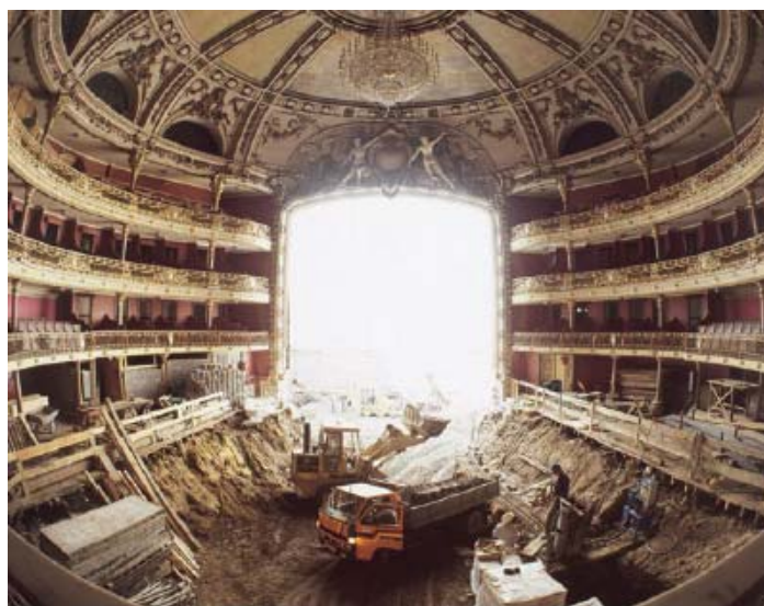
Figura 19: Vista do início dos trabalhos de escavação na mesma zona (Pinto et al., 2004a)
