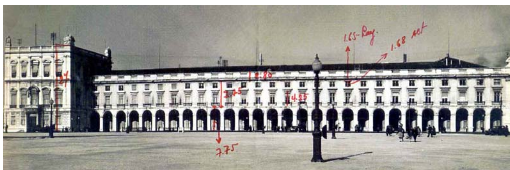
Figura 32: Assentamento exibido pela Ala Ocidental do Terreiro do Paço em Lisboa (Arantes de Oliveira, 2005)
