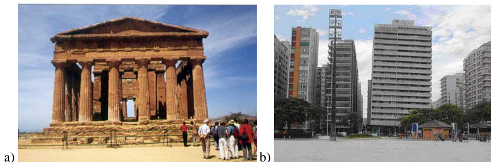
Figura 7: Exemplos de danos (a) arquitectónicos: templo romano; (b) funcionais: edifícios em Santos (Cothechia, 1997 e Milititsky et al., 2005)
