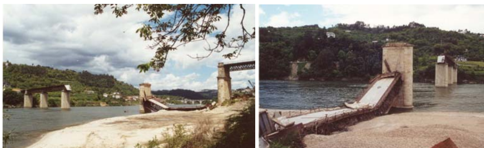
Figura 8: Colapso da Ponte Hintze-Ribeiro em Entre-os-Rios (2001): sobreescavação
