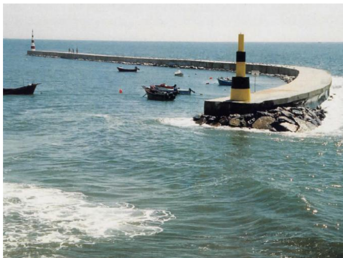
Fig. 4 - Quebramar destacado da Aguda, 2002. [3]
