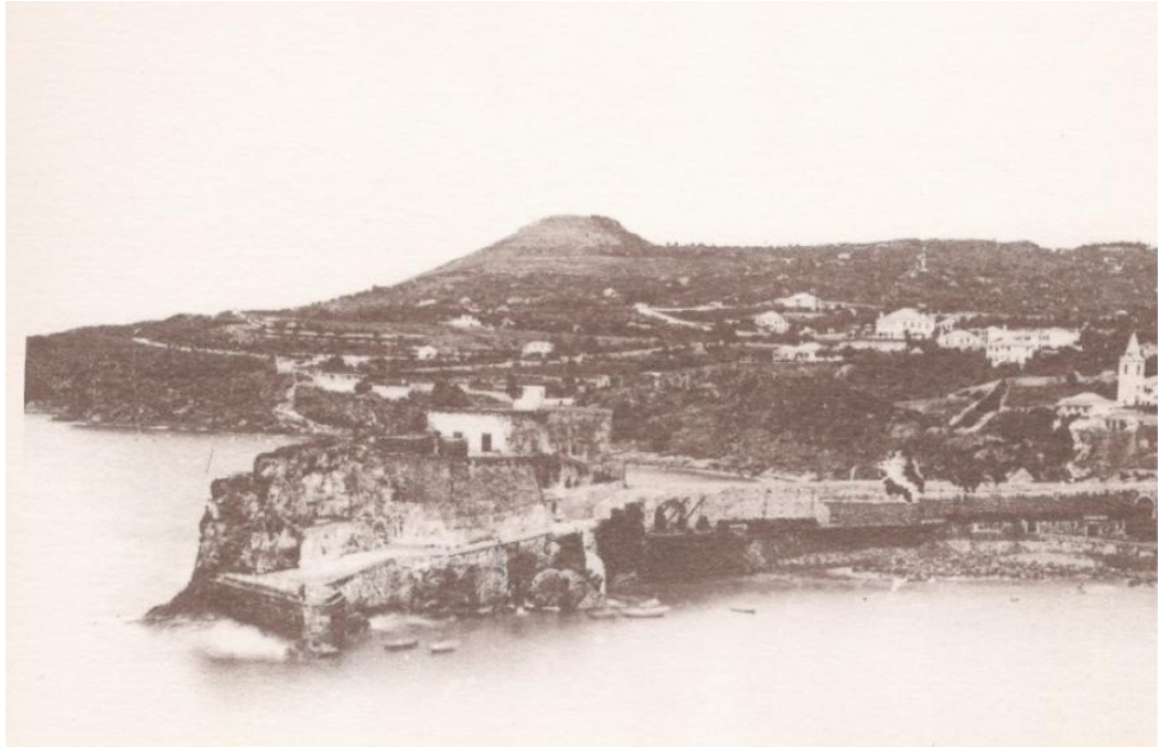
Fig. 7 – Porto de abrigo constituído pelo cais que fazia a ligação do Ilhéu do Forte de S. José até à costa, anterior a 1885. [1]
