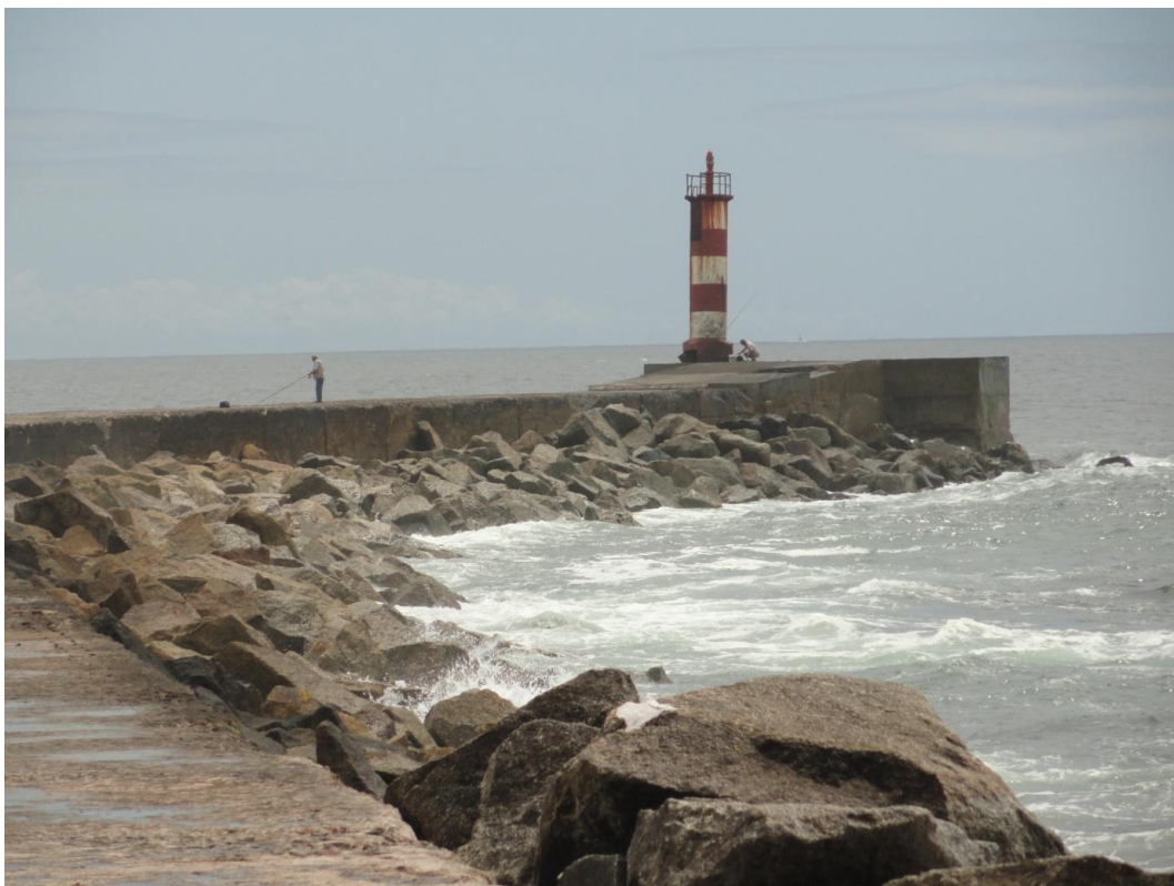
Figura 2.21 - Quebramar norte de Vila do Conde, 2012
