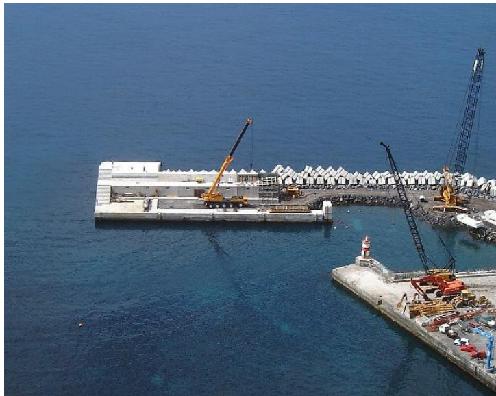
Fig. 10 - Fase construtiva do quebramar 4, 2002. [1]
