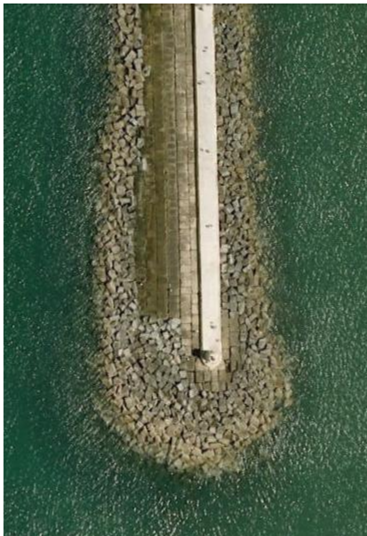
Fig. 6 – Quebramar oeste do porto de Portimão, imagem Google, 2007.
