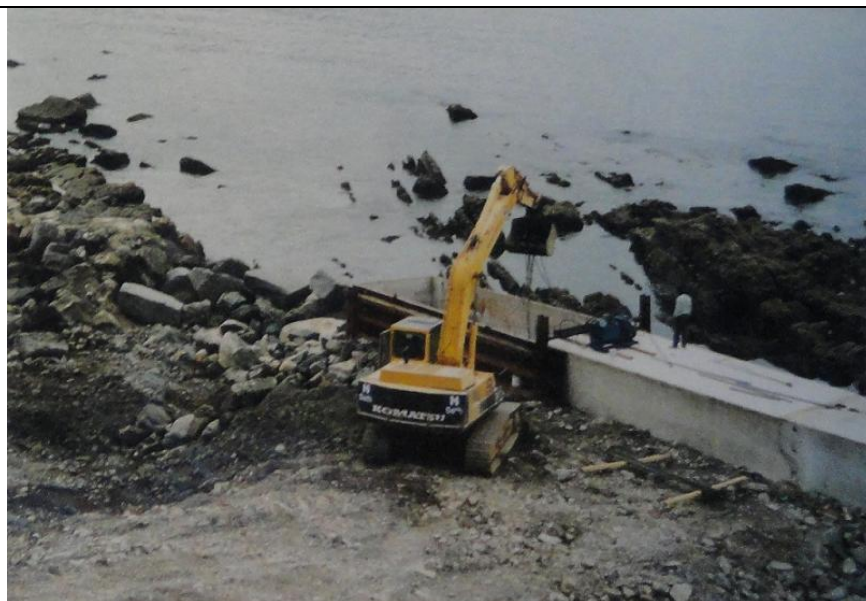
Fig. 5 - Fase construtiva do quebramar do porto de pesca da Arrifana. [2]
