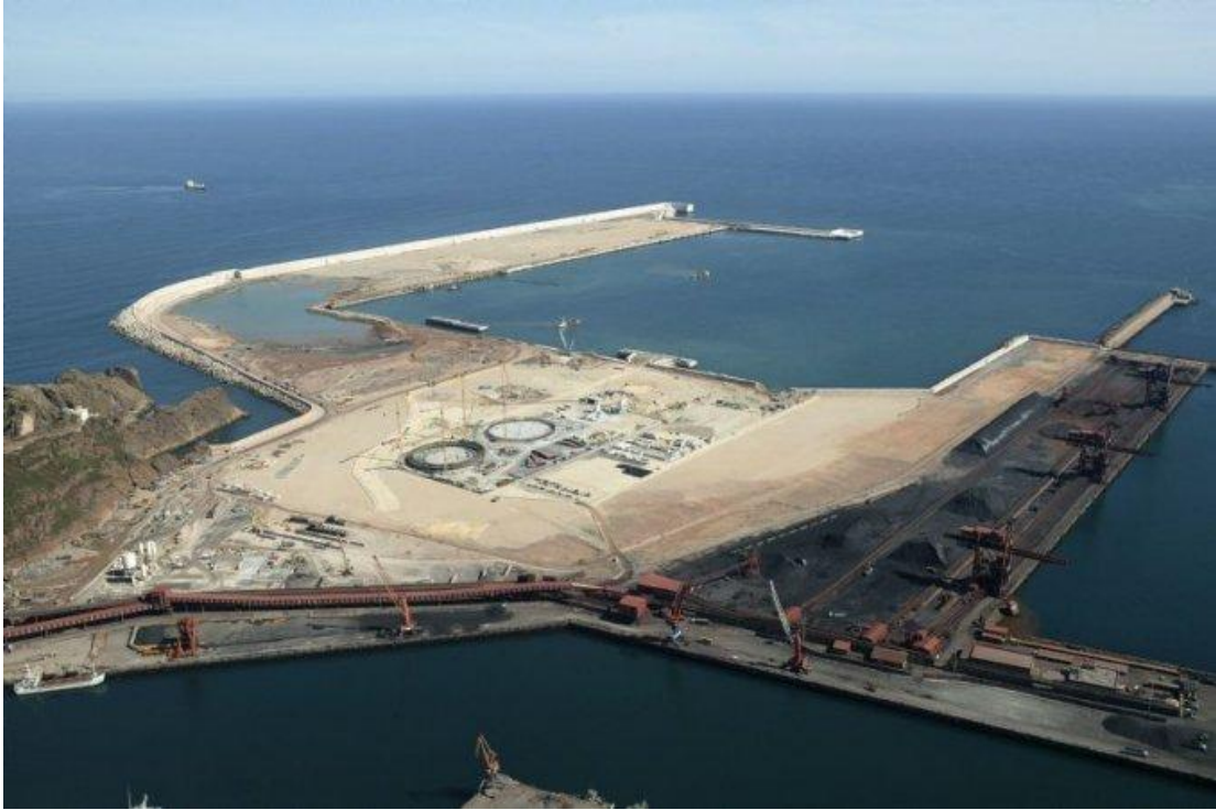
Figura 4.36 - Quebramar Torres, Porto de Gijón, 2010. [15]
