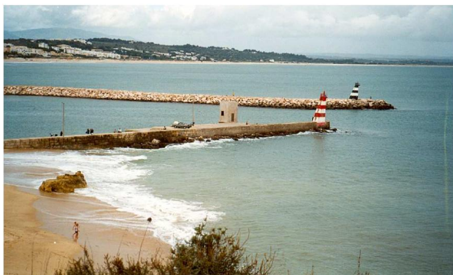
Fig. 6 - Aspeto geral dos quebramares de entrada do porto de Lagos. [2]
