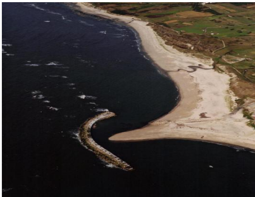
Fig. 8 - Quebramar de Castelo do Neiva, 2000. [1]
