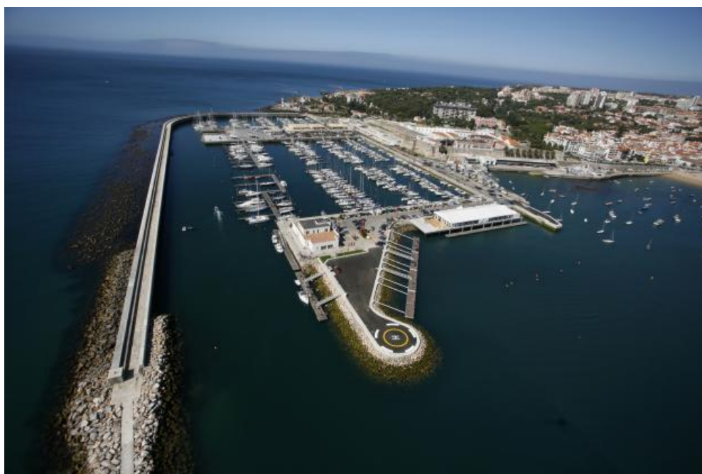
Fig. 4 - Marina de Cascais. [3]
