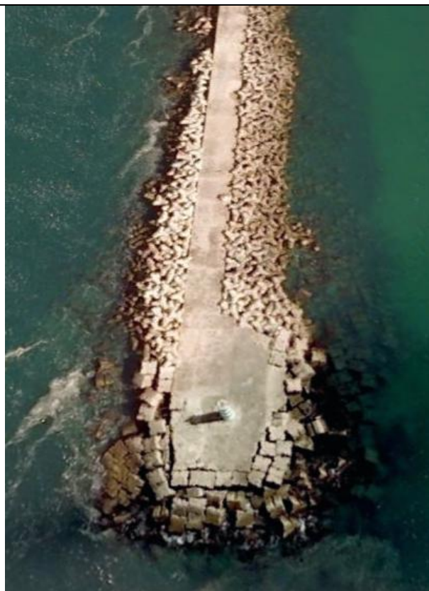
Fig. 8 - Quebramar este da Barra de Faro/Olhão, zona da cabeça, imagem Google, 2007. Ainda de referir que na zona das cabeças dos dois quebramares se tem verificado um grande aprofundamento de -12,5m para -30m relativamente ao Z.H.. [3]
