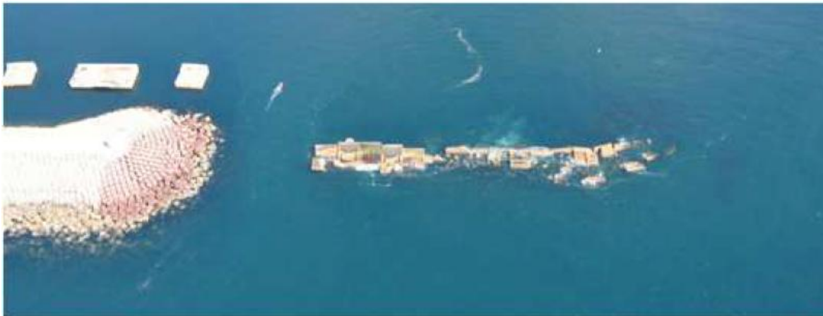
Fig. 21 – Destroços do quebramar oeste original do porto de Sines, 1992. [3]
