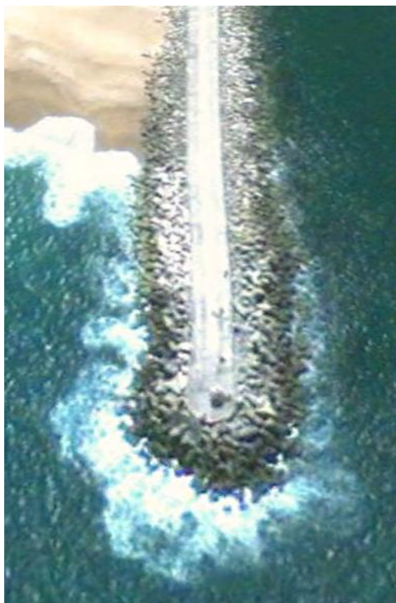
Fig. 6- Quebramar norte do porto da Nazaré, imagem Google, 2009.
