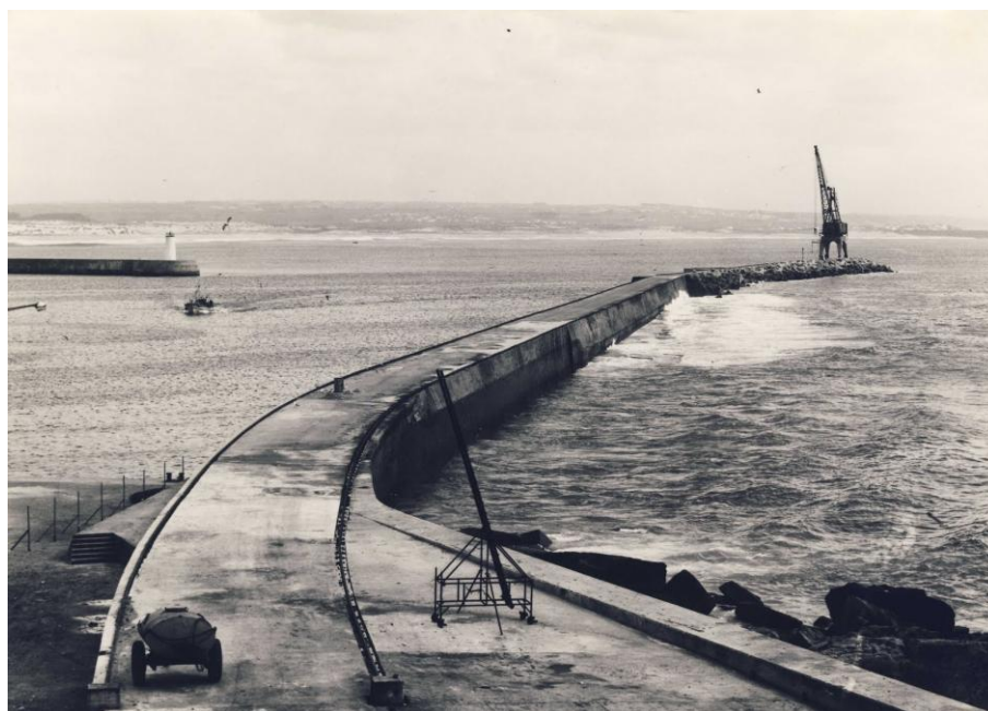
Fig. 8 - Prolongamento do molhe Oeste do porto de Peniche, anos 40. [5]
