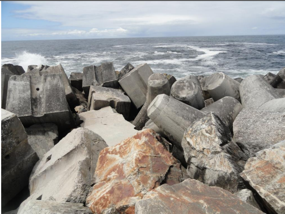
Fig. 8 – Blocos de enrocamento, tetrápodes e Antifer do quebramar norte do Porto da Póvoa de Varzim, 2012.
