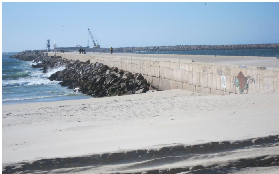
Figura 2.2 - Quebramar sul do porto de Aveiro, exemplo de um quebramar artificial enraizado, 2012.
