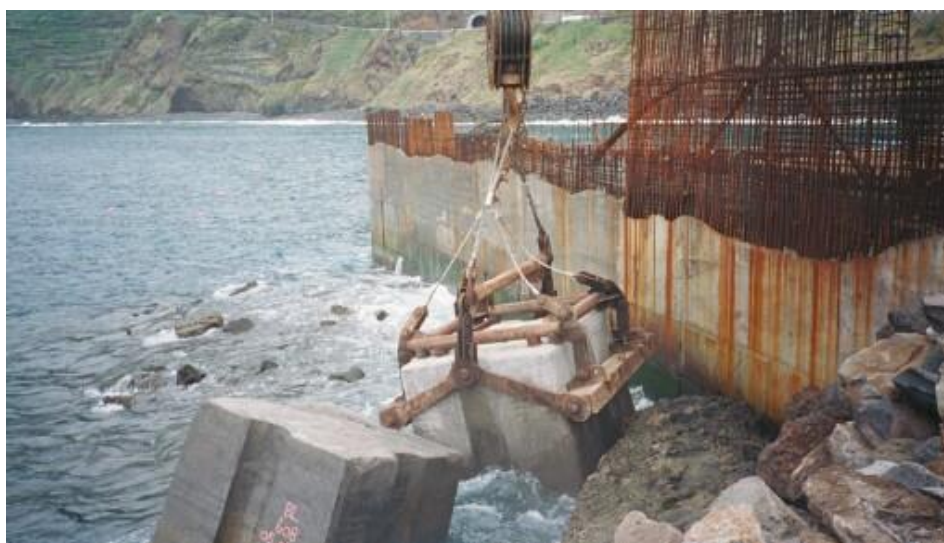
Fig. 10 - Colocação de um bloco Antifer no porto de abrigo de Porto Moniz, 2003.
