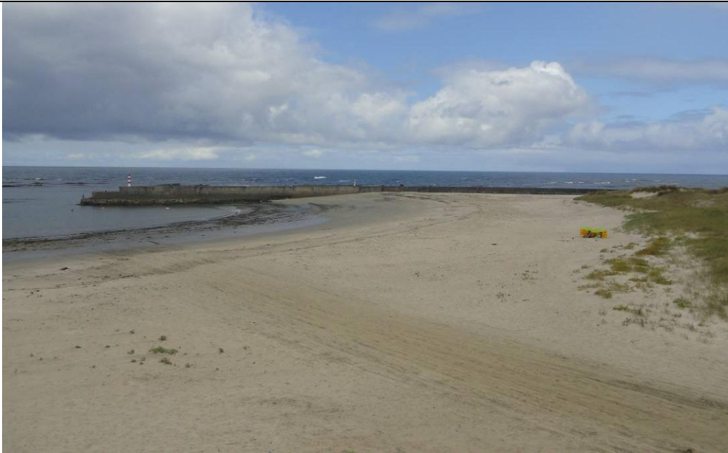
Fig. 9 - Quebramar de Castelo de Neiva, 2012.
