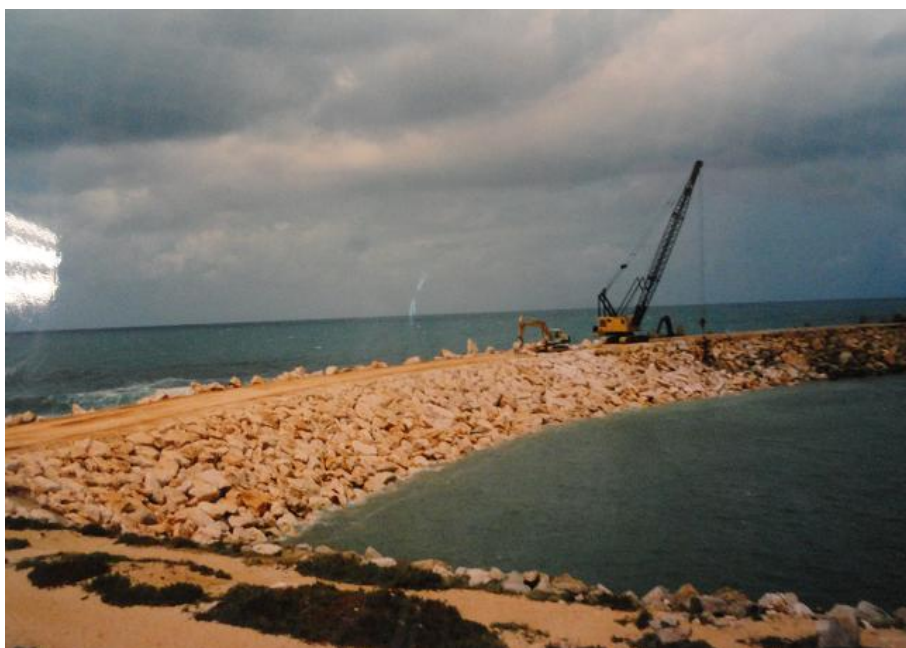
Fig. 8- Fase de reacondicionamento do molhe sul, 1997. [5]
