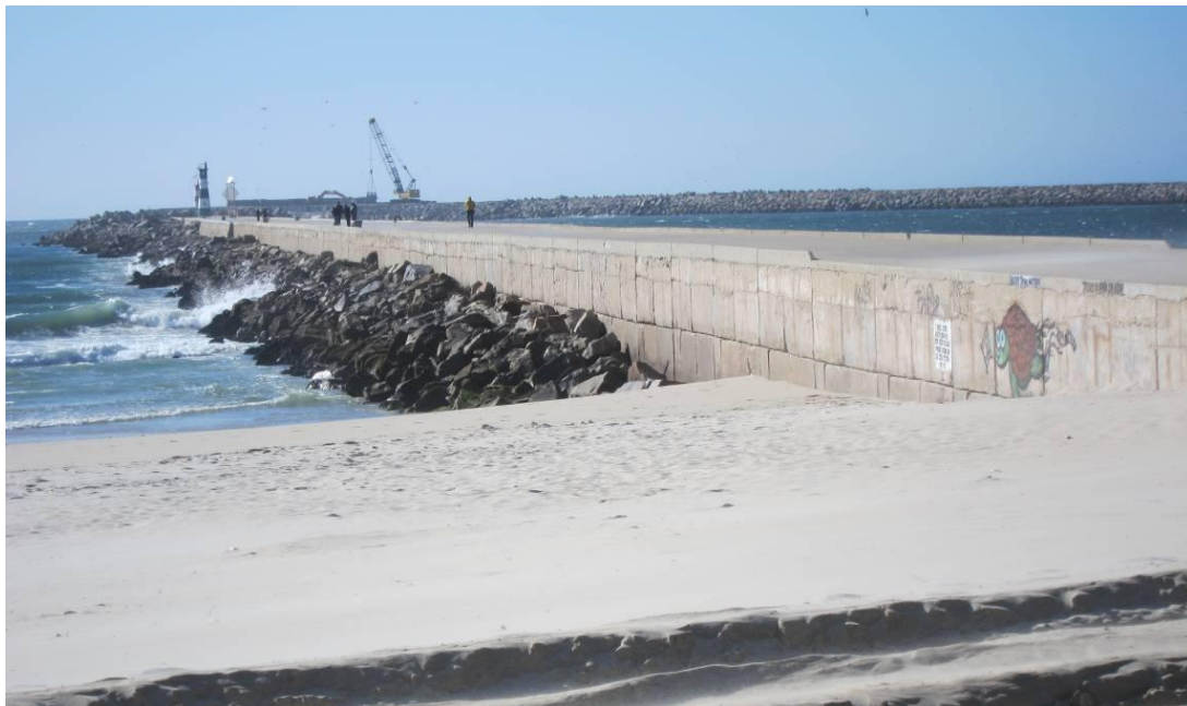
Fig. 7 - Vista das obras de prolongamento do quebramar norte do porto de Aveiro, a partir do molhe sul, 2012.
