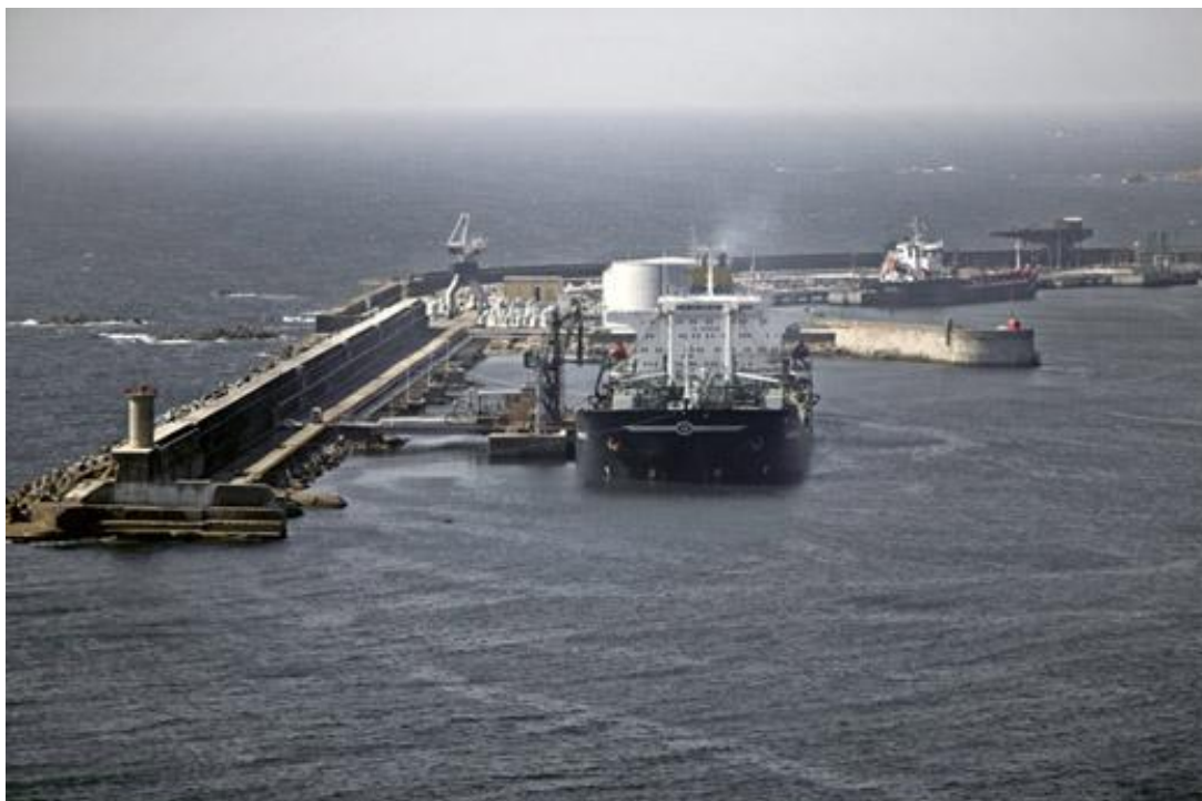
Figura 4.7 – Posto de acostagem de petroleiros no quebramar norte do porto de Leixões. [11]
