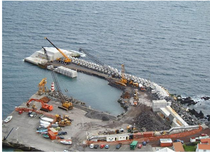
Fig. 8 - Fase construtiva do quebramar da Calheta 2, 2002. [1]
