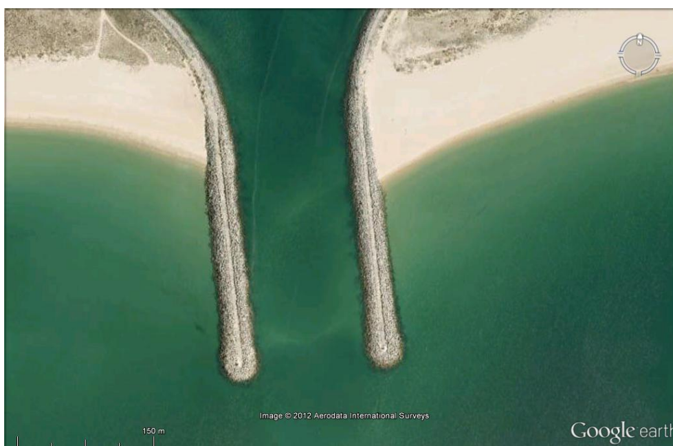
Fig. 2 - Quebramares do núcleo portuário do Alvor, imagem Google de 2007.
