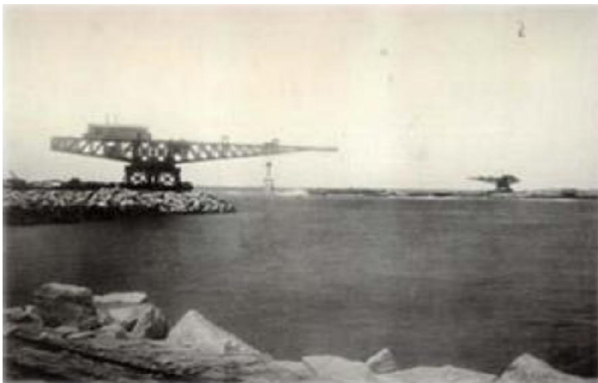
Fig. 10 – Construção do molhe norte e sul do porto de Leixões, 1884 – 1892. [5]
