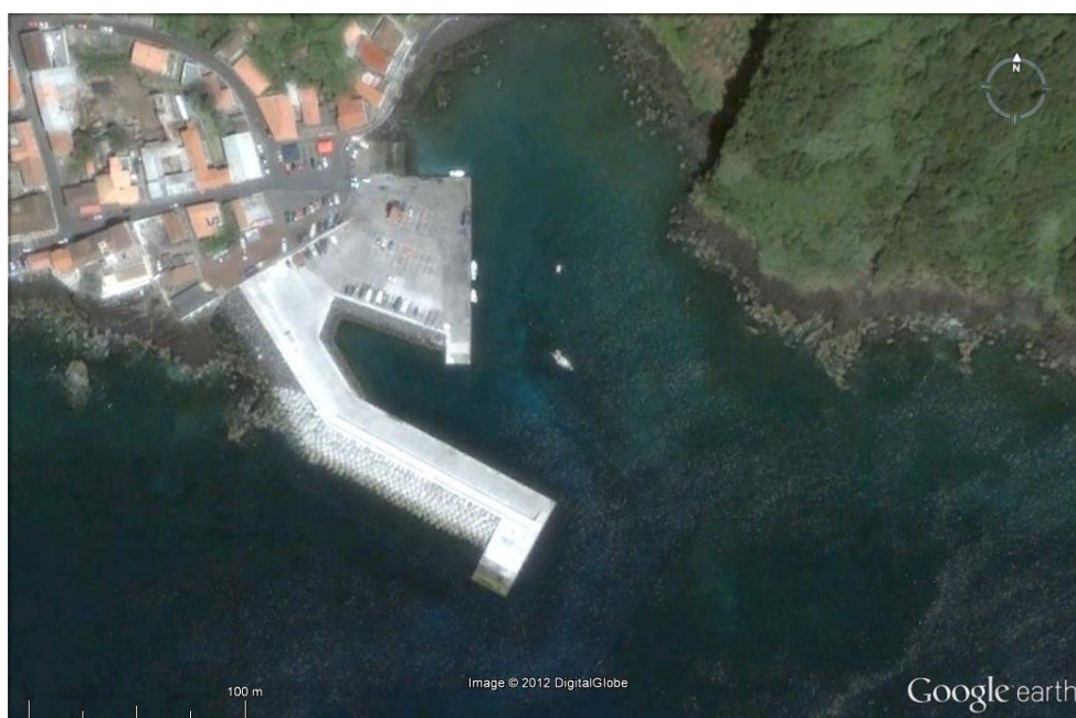
Fig. 2 - Quebramar do Porto da Calheta, imagem Google de 2004.
