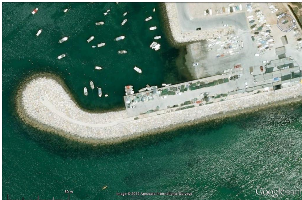
Fig. 3 - Quebramar Este do porto de abrigo de Albufeira, imagem Google de 2007.
