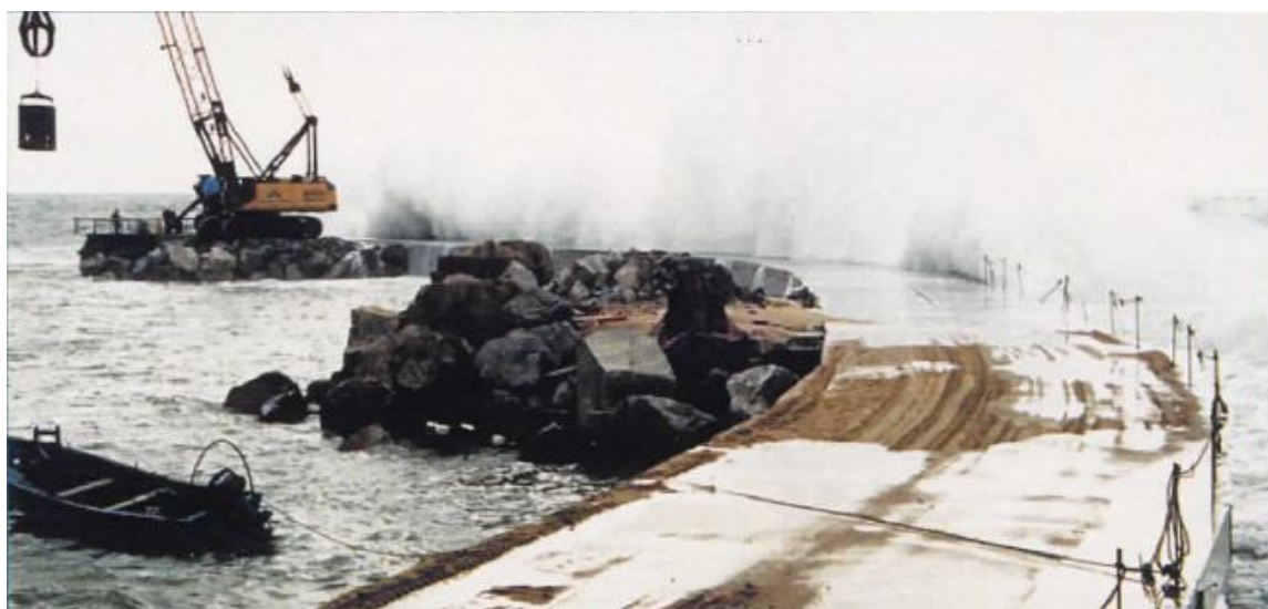
Fig. 8 - Colocação do enrocamento, quebramar destacado da Aguda. [4]
