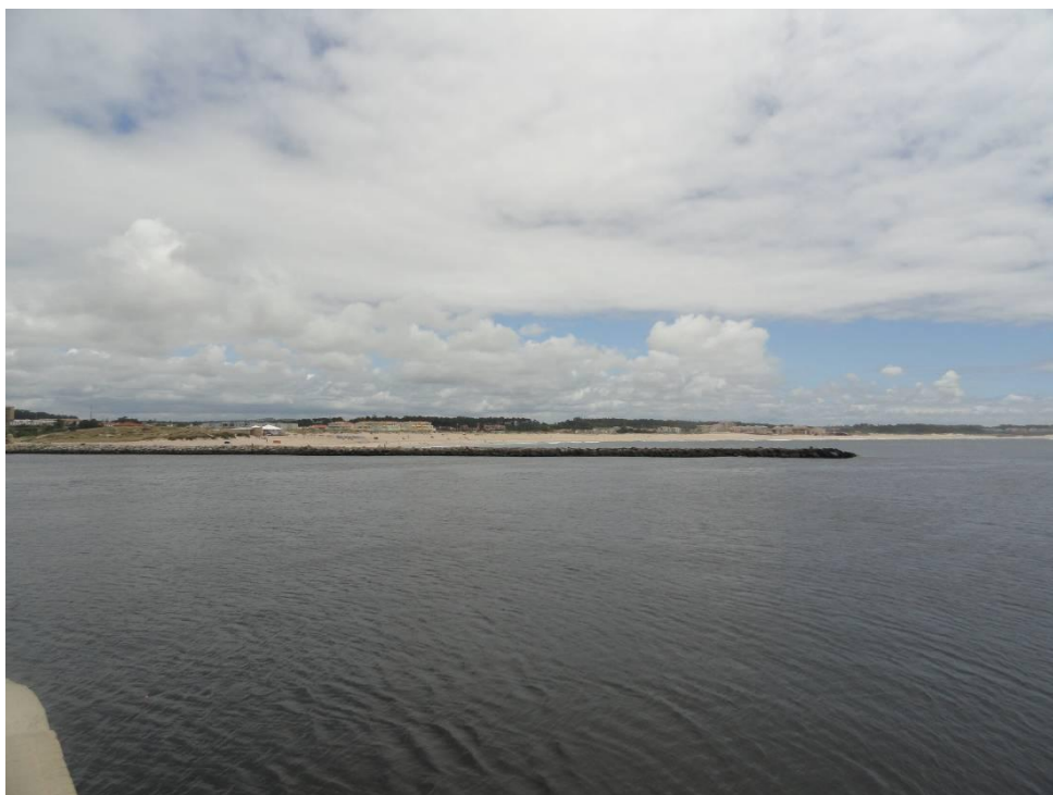
Fig. 6 - Quebramar sul do porto de Vila do Conde, 2012
