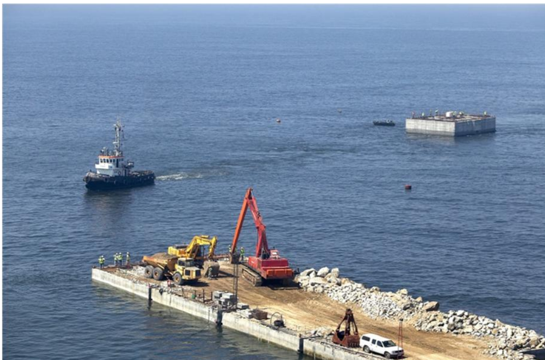
Fig. 8 - Reboque por via marítima dos caixotões para o molhe Norte dos Molhes do Douro. [5]
