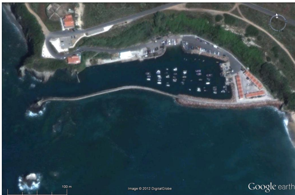
Fig. 2 - Quebramar do portinho de Vila Nova de Milfontes, imagem Google de 2011.
