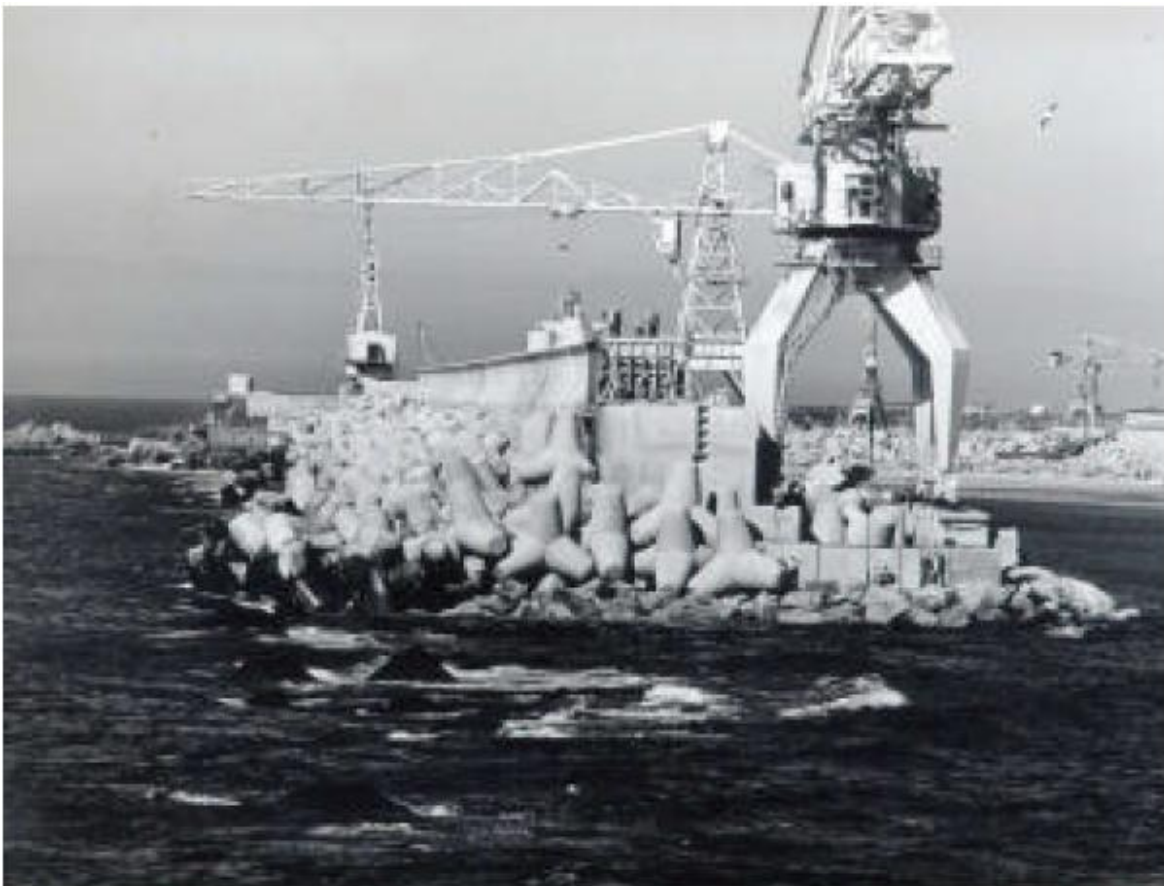
Fig. 14 – Alteamento do quebramar submerso, anos 60. [3]
