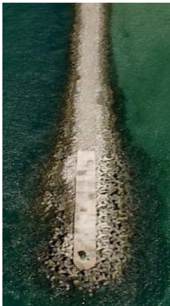
Fig. 5 - Quebramar este da Barra de Tavira, imagem Google, 2007.
