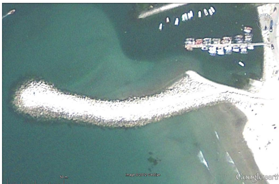
Fig. 3 - Quebramar sul do Portinho de Vila Praia de Âncora, imagem Google de 2010.
