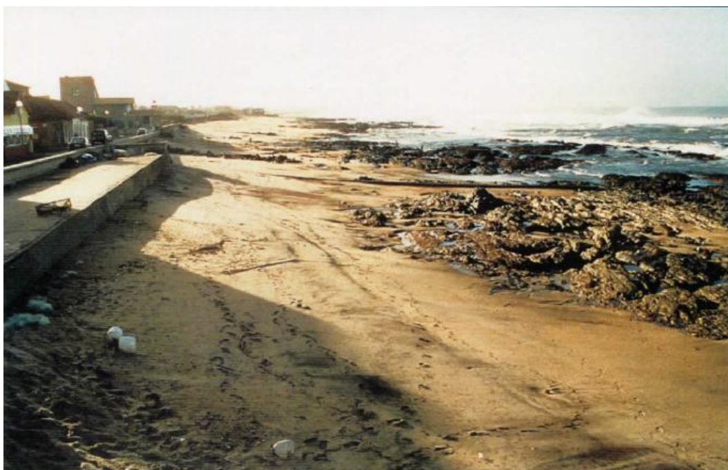
Fig. 10 - Praia da Aguda, antes da construção do quebramar destacado da Aguda. [4]
