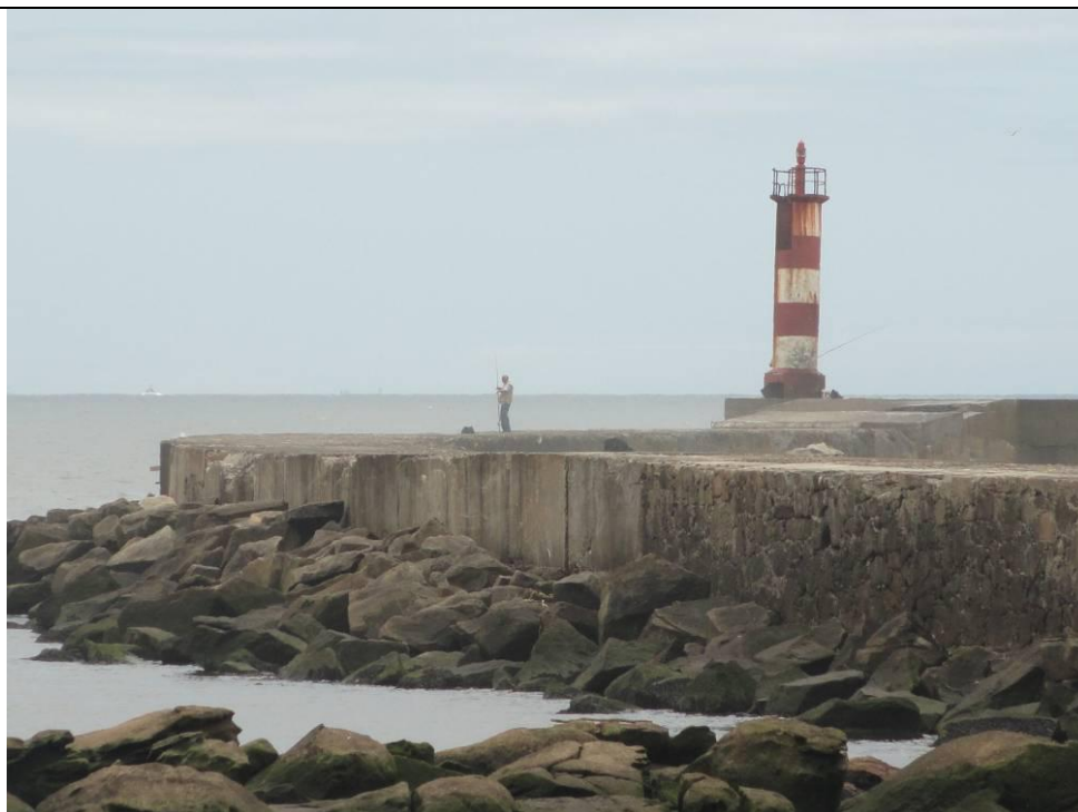
Fig. 5 – Quebramar norte do porto de Viana do Castelo, 2012.
