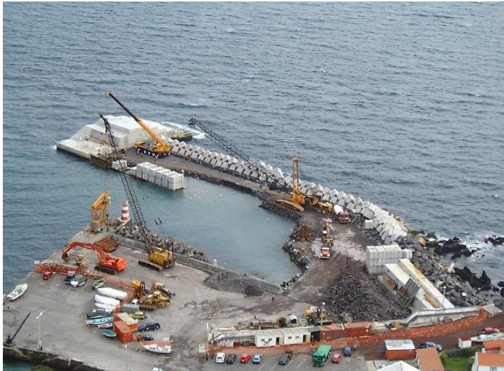
Fig. 9 - Fase construtiva do quebramar 3, 2002. [1]
