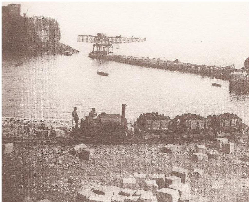
Fig. 8 - Construção do cais de ligação ao Ilhéu do Forte da Nossa Senhora da Conceição, 1888. [1]
