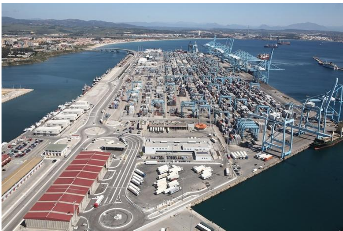
Figura 4.40 - Porto de Algeciras, 2011. [17]
