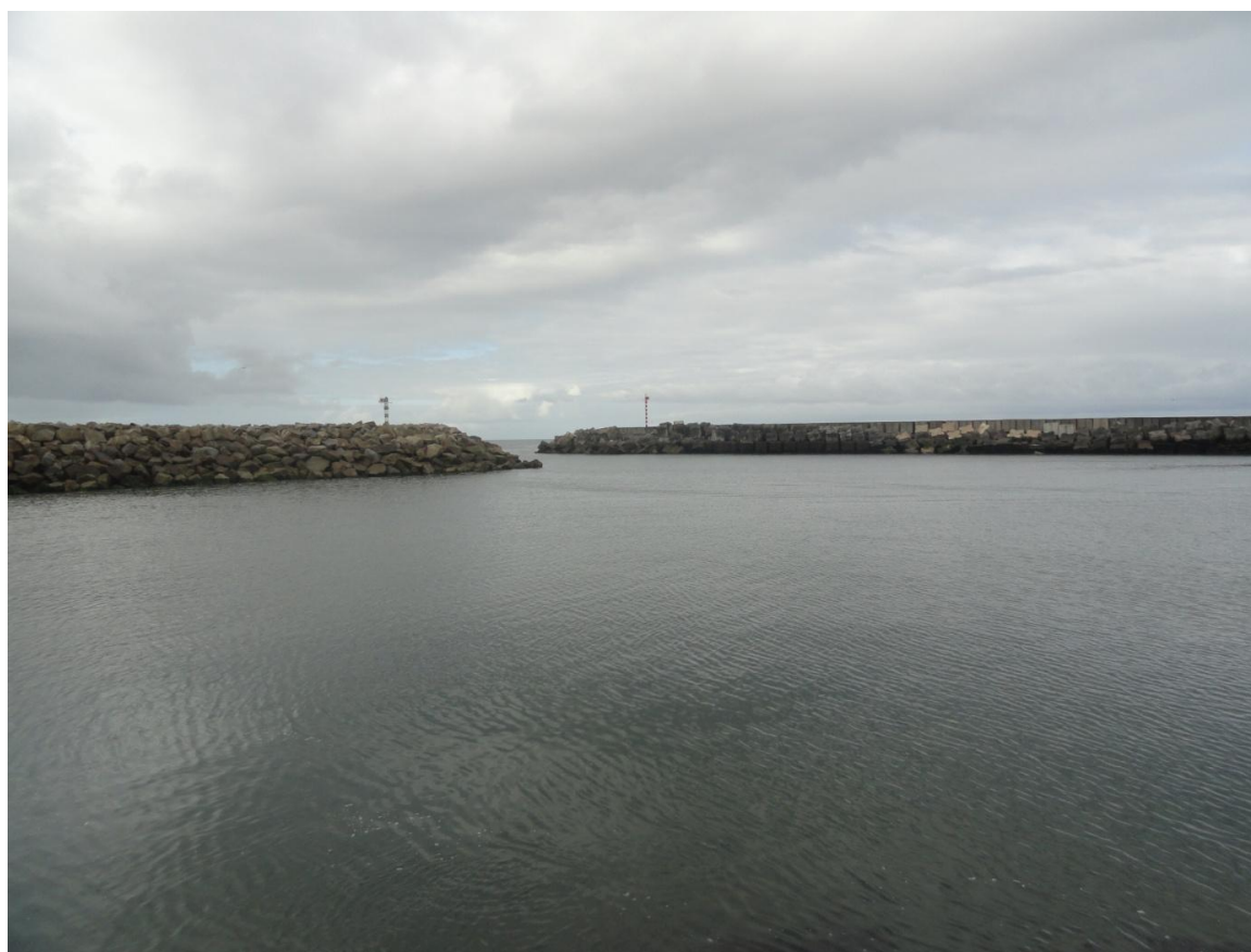
Figura 4.14 - Mantos interiores dos quebramares norte e sul do portinho de Vila Praia de Âncora, 2012.
