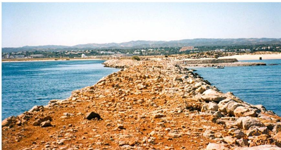
Fig. 6 - Coroamento do quebramar este da Barra de Tavira, 1995. [1]
