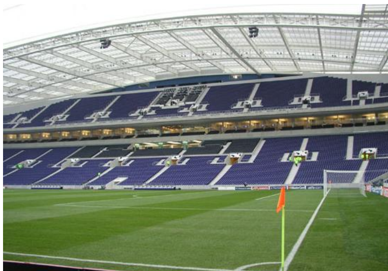
Figura 13 – Estádio do Dragão
