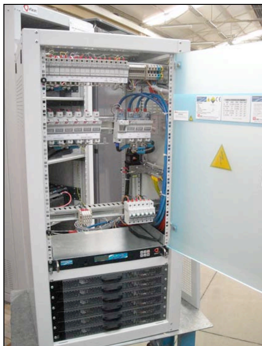
Figura 3.3 -Interior do EFAPOWER CIB S 48V / 6X50A C/ MÓDULOS SMi2800.
