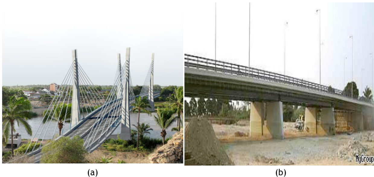
Figura 3 - a) Ponte sobre o rio Catumbela, b) Ponte sobre o rio Cavaco.
