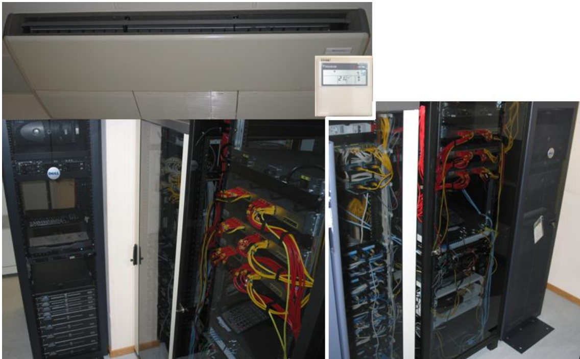
Figura 78 Pólo técnico do Porto remodelado
