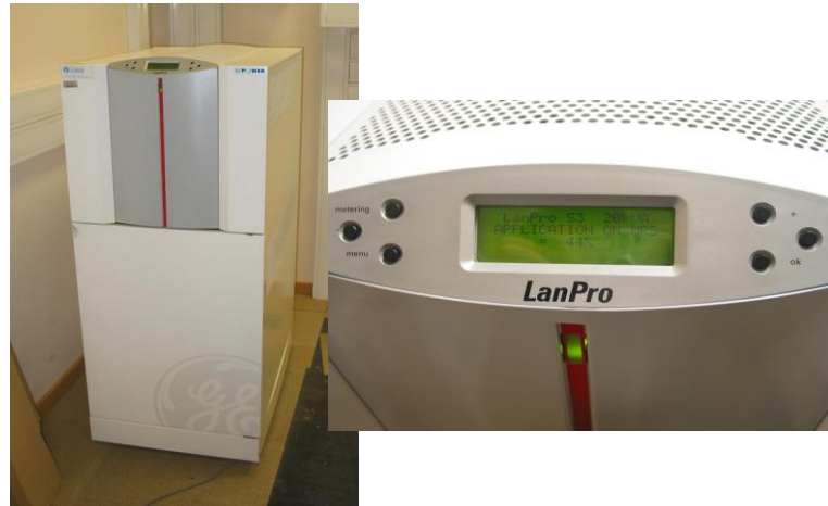
Figura 15 Fotografias do sistema de socorro da alimentação eléctrica do Pólo técnico do Porto
