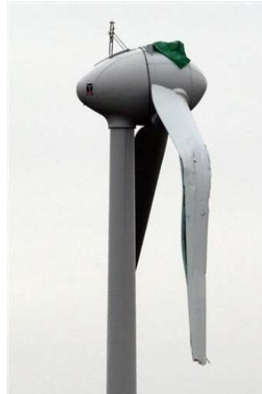
Figura 48- Dano devido a fadiga [2.23]
