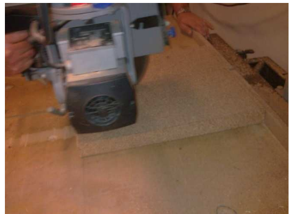
Figura 168- Corte das placas de aglomerado de cortiça
