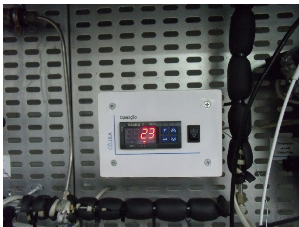
Figura IV.6 - Imagem do sistema de controlo de temperatura de operação da célula.
