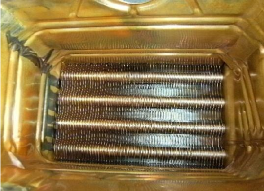
Figura 29 – Bloco de lamelas observado a partir do interior da câmara de combustão.
