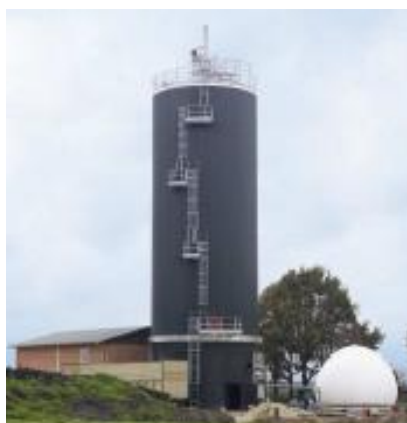
Digestor Anaeróbio Dranco
