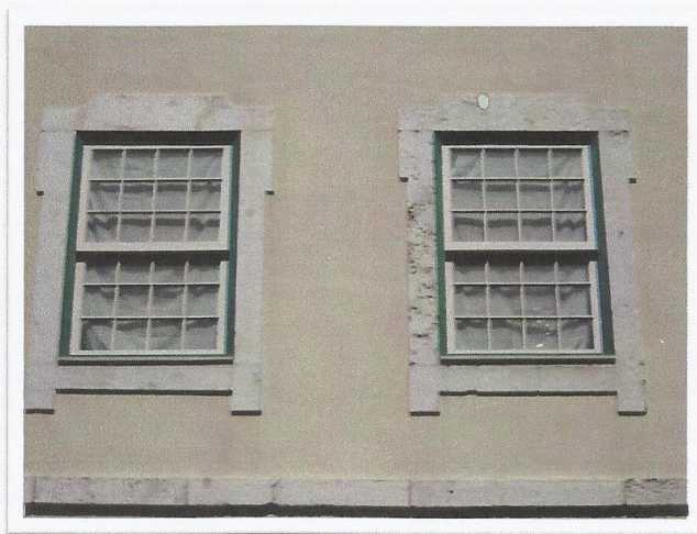
Rua Augusta, lote nº 222 Detalhe das janelas - 1.º andar.
