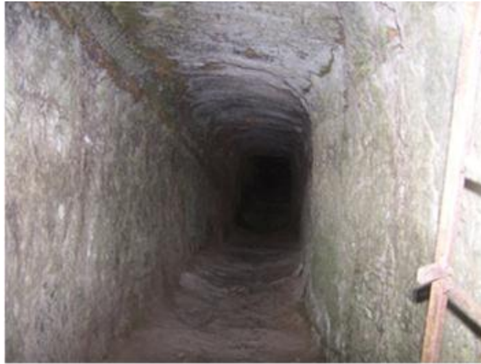
Fig. 8 Fojo das Pombas (provável entrada de água para as galerias)
