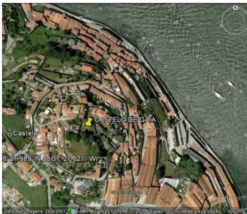
Fig. 55 Vista Aérea do Castelo de Gaia (Fonte: Google Earth)
