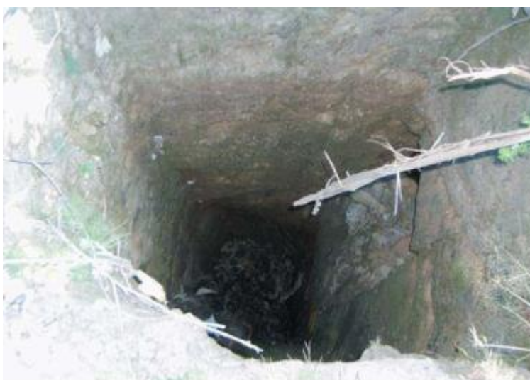
Fig. 209 Poço de Secção Quadrangular - Banjas 190
