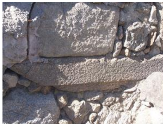
Fig. 59 Muro com Aproveitamento de Padieira, Castelo de Gaia
