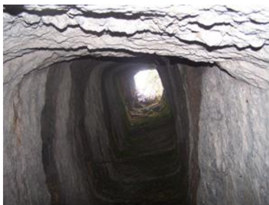
Fig. 204 Poço de Secção Quadrangular - respiradouro
