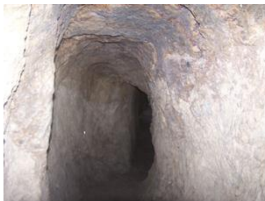
Fig. 201 Galeria de Secção Retangular, Mina G1
