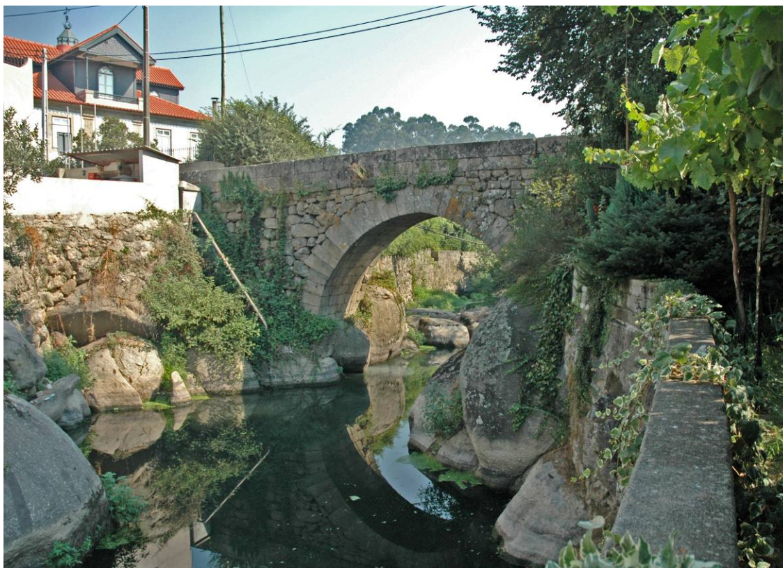
Fig. 2 Ponte de Cepeda sobre o rio Sousa
