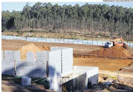
As obras devem estar concluídas dentro de quatro ou cinco meses
