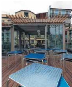
Igespar mandou demolir
