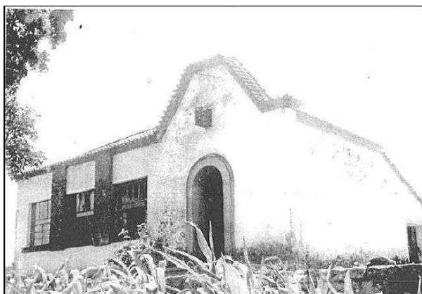
Imagem 12 Fachada Principal Escola da Cabração. Fonte: Arquivo Municipal de Ponte de Lima
