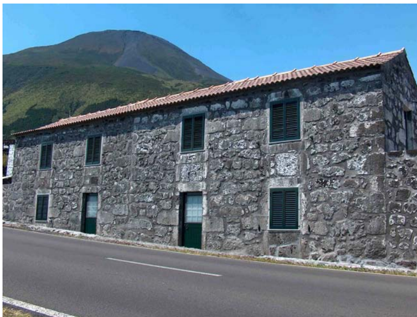
Fig.3.8 – Edifício com paredes em alvenaria de pedra de junta argamassada [ http://casadasbaixas.com/Frente.jpg ].
