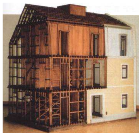
Fig.3.11 – Gaiola tridimensional de madeira, característica da construção pombalina, após o sismo de 1755 [Lamego, 2007].
