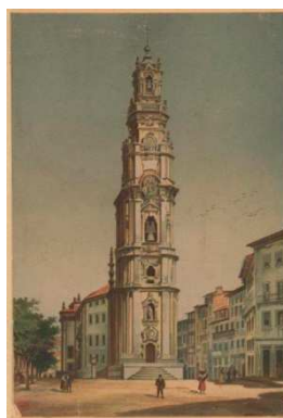
Fig. 5.2.: Litografia do final do séc. XIX da Igreja e Torre dos Clérigos, obra arquitectónica da autoria de Nicolau Nasoni [75].
