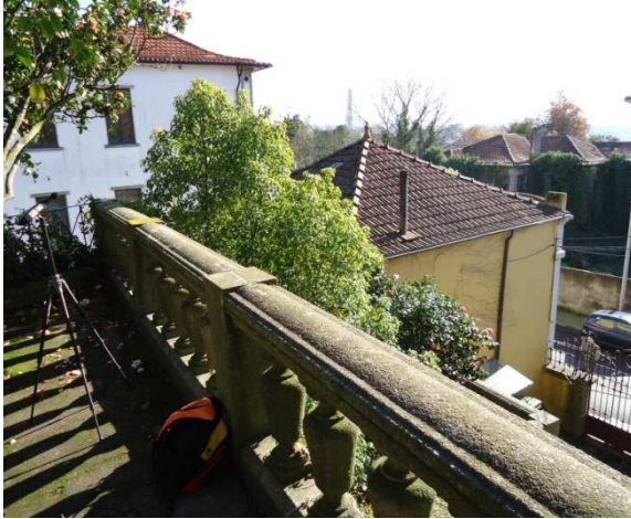
Fig. 6.27.: Meditação no limite Sul do Parque de São Roque, com acesso à Rua São Roque da Lameira [fotografia do autor].
