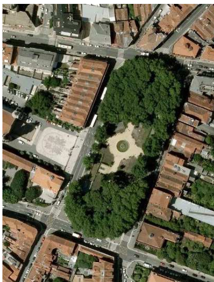
Fig. 6.5.: Fotografia aérea do Jardim da Praça do Marquês [84].
